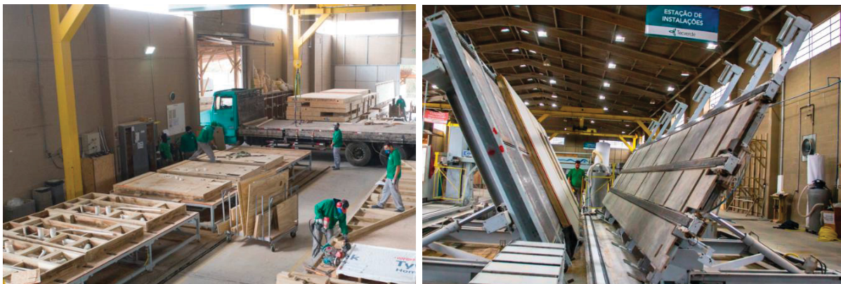
FIGURA 57 – Processo industrial de montagem de painéis em wood frame
