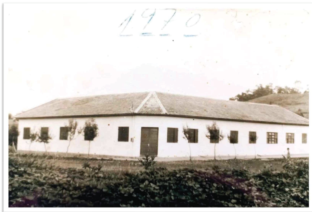
Imagem 53 – HOSPITAL BENEFICENTE GUARUJÁ DO SUL, EM 1970.
