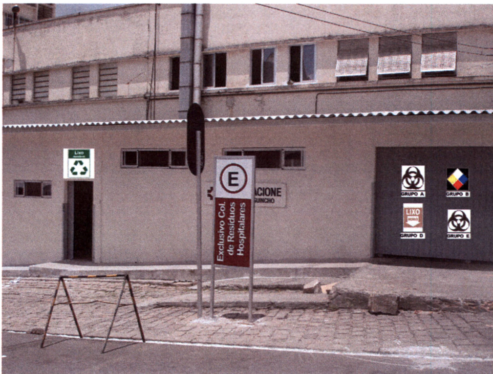
Figura 08: Vista externa do abrigo de resíduos do HC. Nov./2009.
