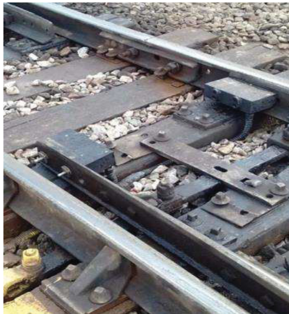
Figura 24. Sensores de Ponta de Agulha
