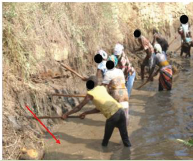
Limpeza no canal de captação de água, pelos agricultores
