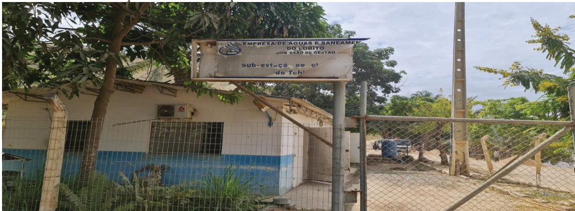
FIGURA 11: SUBESTAÇÃO DE CLORAÇÃO DO TCHIÚLE
