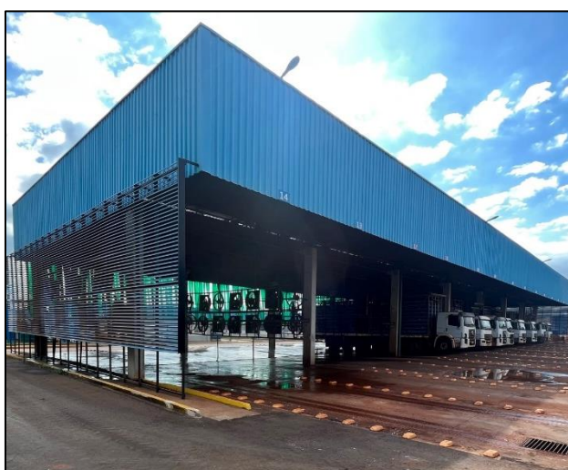
FIGURA 4 – GALPÃO DE ESPERA VIVA.
