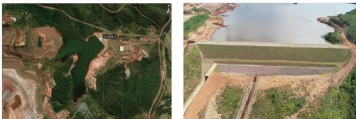
FIGURA 4.3 Detalhe do Dique de Contenção de Sedimentos 2
