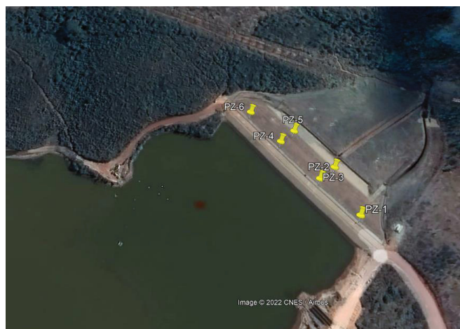
FIGURA 4.11 Locação dos piezômetros localizados no Dique 2
