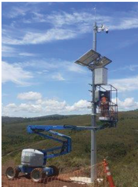
FIGURA 3.14 Instalação do concentrador de dados ( gateway )
