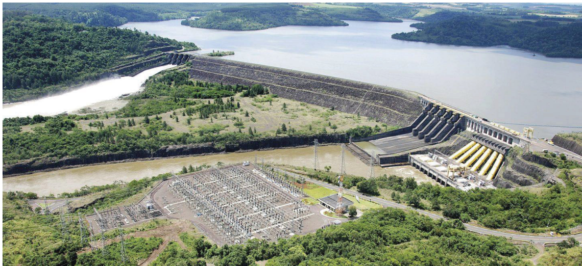
FIGURA 6 - VISTA PANORÂMICA DE PARTE DA UHE SALTO SANTIAGO
