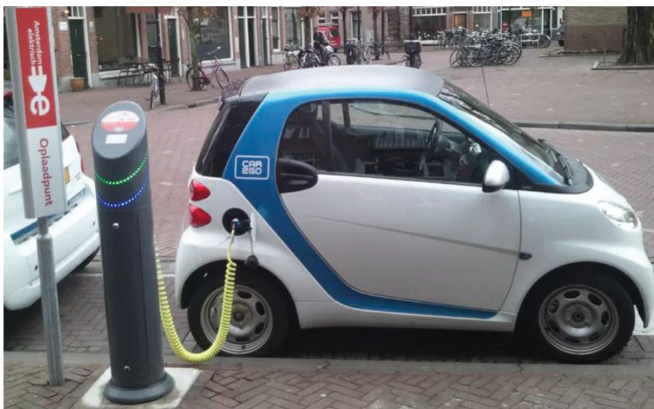
FIGURA 7: VEÍCULO CARREGANDO USANDO CARREGADOR PÚBLICO
