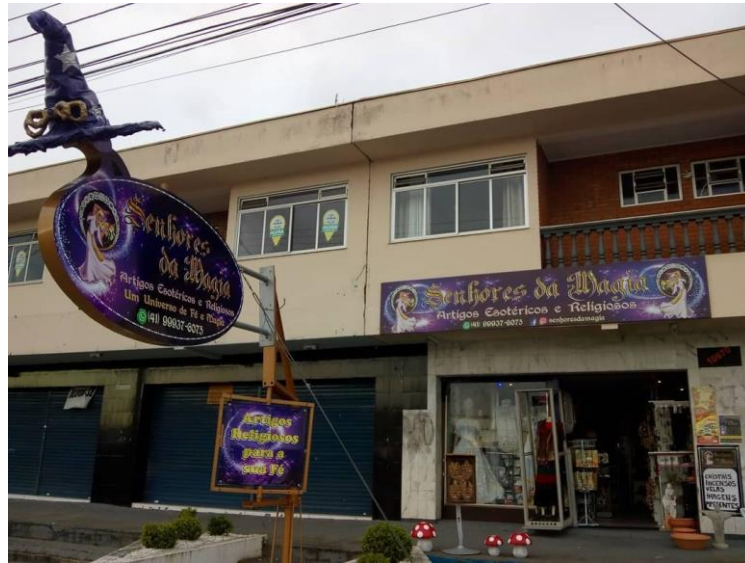
FIGURA 1 - Fachada da loja
