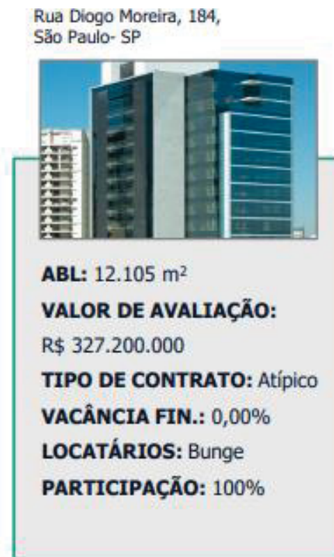
FIGURA 2 - EDIFÍCIO ATRIUM FARIA LIMA DO FII KNRI11
