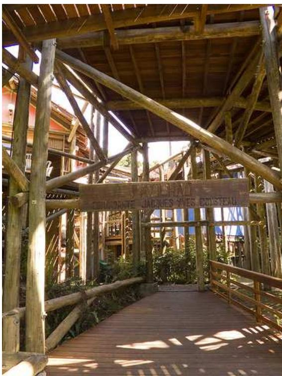
FIGURA 36 - Arrojo no sistema estrutural em eucalipto reciclado
