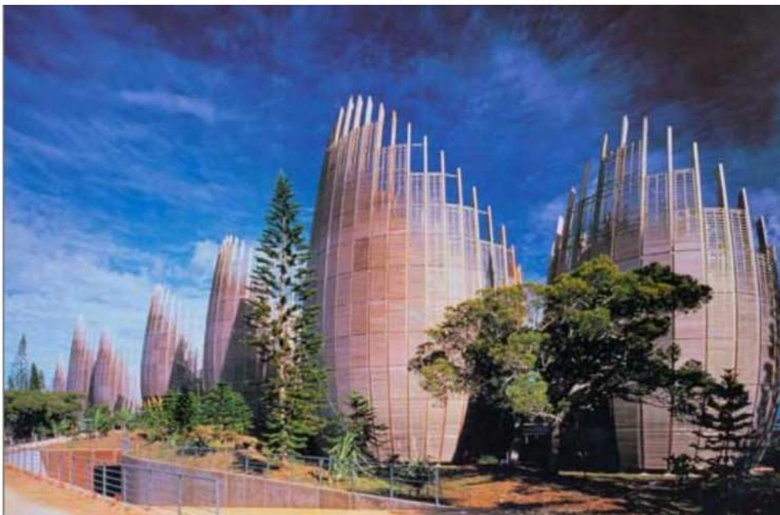
FIGURA 19 – Painéis de madeira e estrutura em aço
