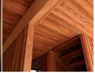
FIGURA 113 - INTERFACE CONSTRUTIVA PILAR VIGA - FLEXIBILIDADE (VILA TAGUAÍ). FONTE: PROJETO (2011)
