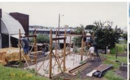
FIGURA 67 - TRAVAMENTO DA ESTRUTURA DE MADEIRA DE EUCALIPTO SERRADO DA UNIDADE 001 (SÃO CARLOS). FONTE: HABIS (1999)
