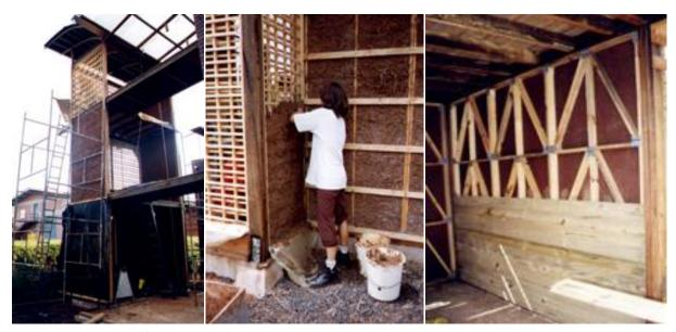
FIGURA 72 - PAINÉIS DE FIGURA 73 - BARREAMENTO TAIPA EXECUTADOS DA UNIDADE 001 (SÃO CARLOS). FONTE: NOMADS (1999)
