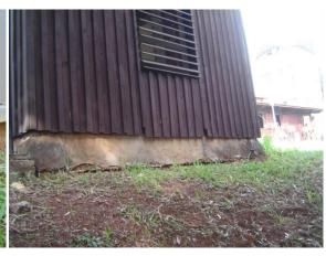
**FIGURA** 79 INTERFACE MADEIRA INTERFACE X TAIPA DE MÃO DE MÃO X SOLO UNIDADE 001.
