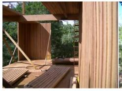
FIGURA 100 - PAINÉIS DE VEDAÇÃO (VILA TAGUAÍ). FONTE: ITA CONSTRUTORA (2010)
