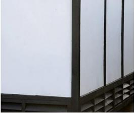
FIGURA 8 - ELEMENTO DE VENTILAÇÃO PERMANENTE NA PORÇÃO SUPERIOR DA EDIFICAÇÃO (MÓDULO 10X10). FONTE: S-AR (2006)
