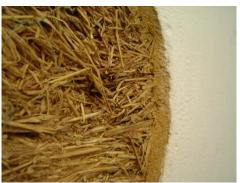
FIGURA 51 - PAREDE DE TERRA-PALHA UNIDADE EXPERIMENTAL 002 (SÃO CARLOS). FONTE: A autora (2012)
