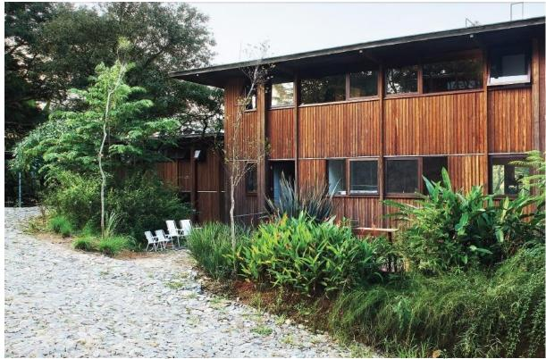
FIGURA 114 - SEM PROTEÇÃO, MADEIRA VAI VARIAR CONFORME A ESTAÇÃO DO ANO (VILA TAGUAÍ).
