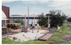
FIGURA 66 - PILARES DE MADEIRA DE EUCALIPTO SERRADO DA UNIDADE 001 (SÃO CARLOS). FONTE: HABIS (1999)
