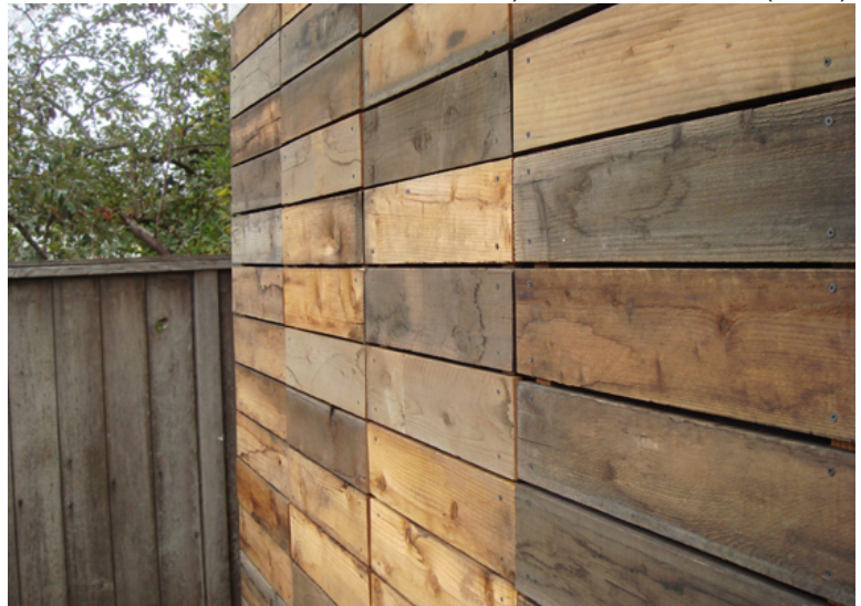
FIGURA 4 - FECHAMENTO DE MADEIRA REUTILIZADA (PETALUMA STUDIO). FONTE: SANDY (2009)
