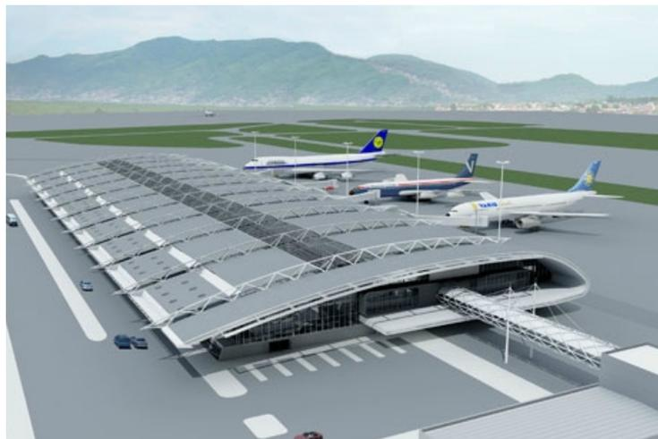
FIGURA 121 – Vista aérea do terminal mostrando arcos treliçados para fora da cobertura
