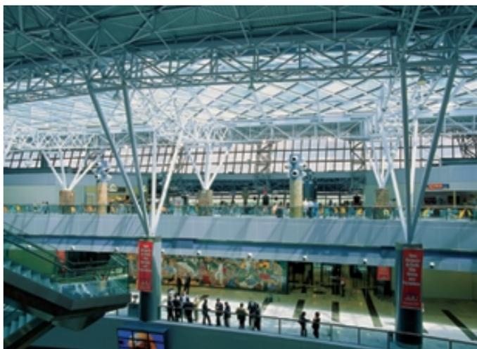
FIGURA 102 – Vista da estrutura da cobertura: treliças de estrutura tubular apoiadas em tirantes que convergem para os pilares
