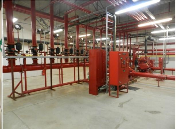
FIGURA 69 – Sistema contra incêndio no subsolo
