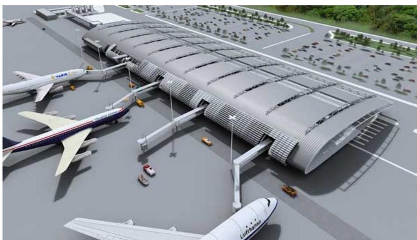
FIGURA 125 – Vista aérea dos conectores protegidos por quebra-sóis e das pontes de embarque
