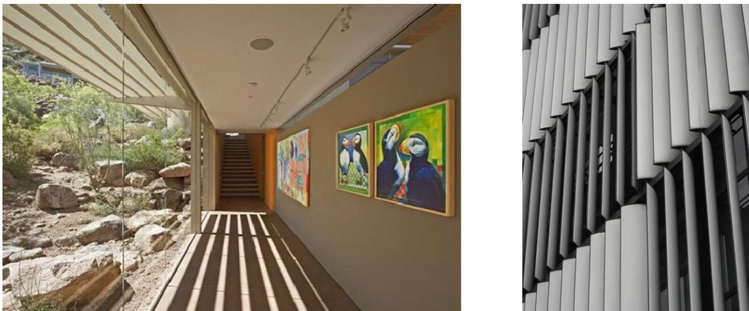
FIGURAS 149 e 150 – Proteções anexas ao edifício: pergolado à esquerda e brises à direita
