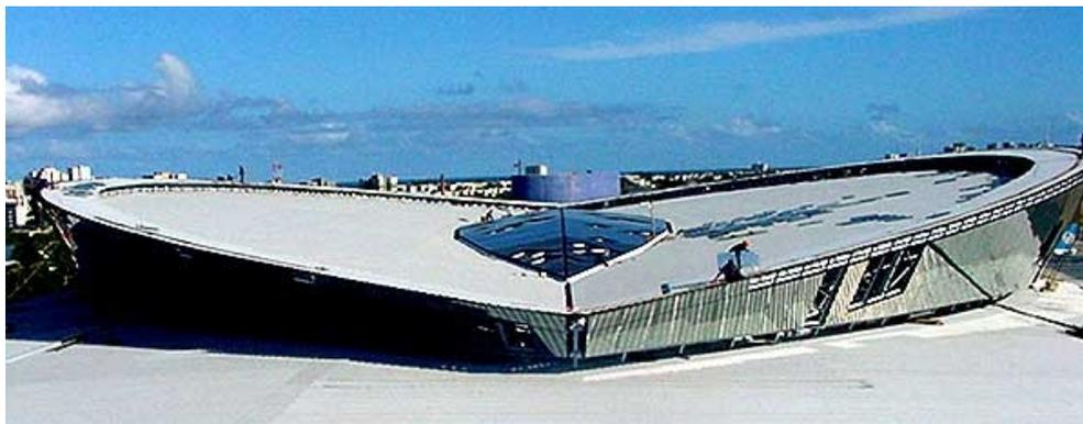
FIGURA 103 – Vista externa da extrusão elíptica, com clarabóia, e seus vidros refletivos inclinados
