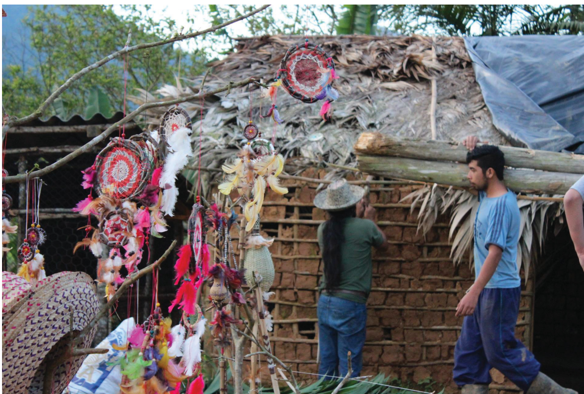
Imagem 2 - Lado externo da primeira Opy (casa de reza) da Tekoa, durante o mutirão em 2016. Na imagem, Rivelino Verá está rebocando a parede de barro com a técnica indígena; Tupã, filho, carrega toras de madeira utilizadas na sustentação da estrutura. Em primeiro plano, a exposição dos artesanatos - Autora: Giorgia Prates
