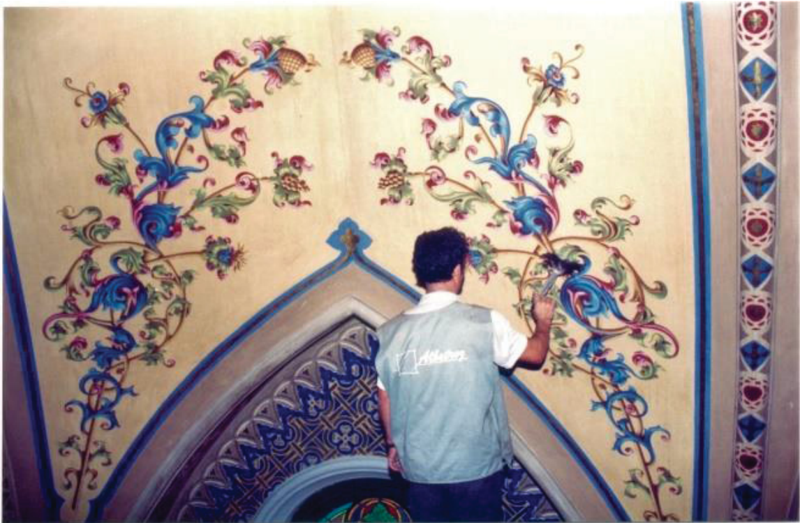
FIGURA 56 – LIMPEZA DE PINTURAS NA ABÓBADA CENTRAL
