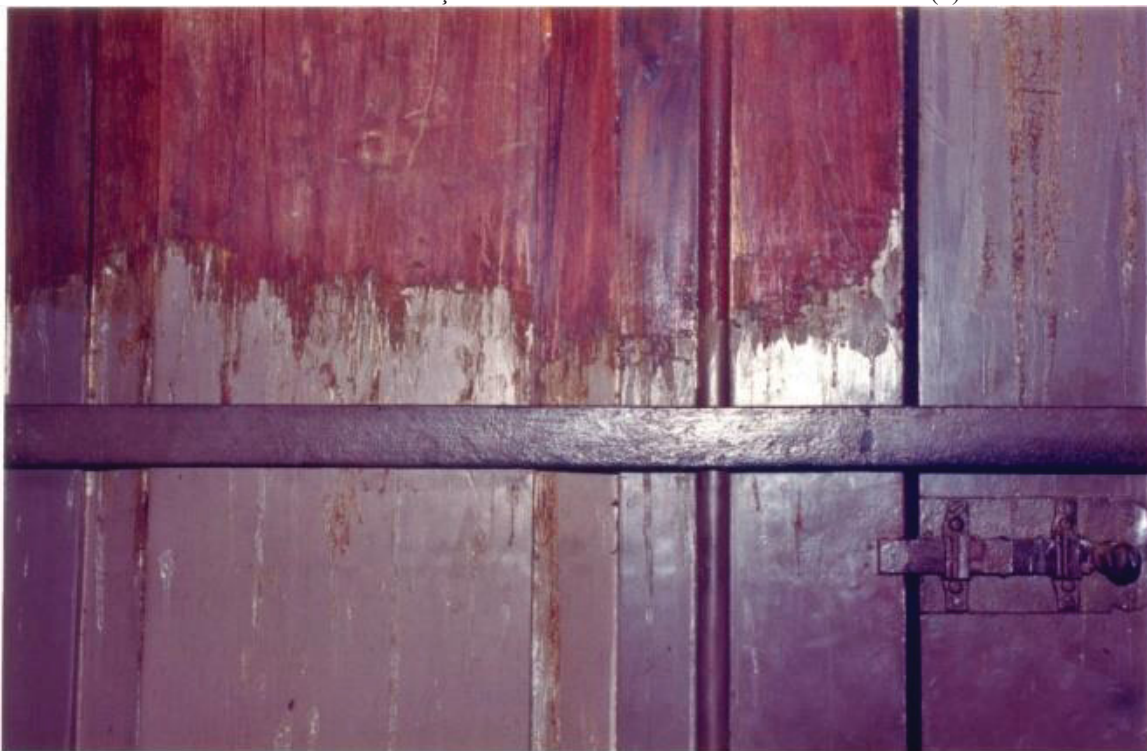
FIGURA 74 – REMOÇÃO DE PINTURA NA PORTA LATERAL (2)
