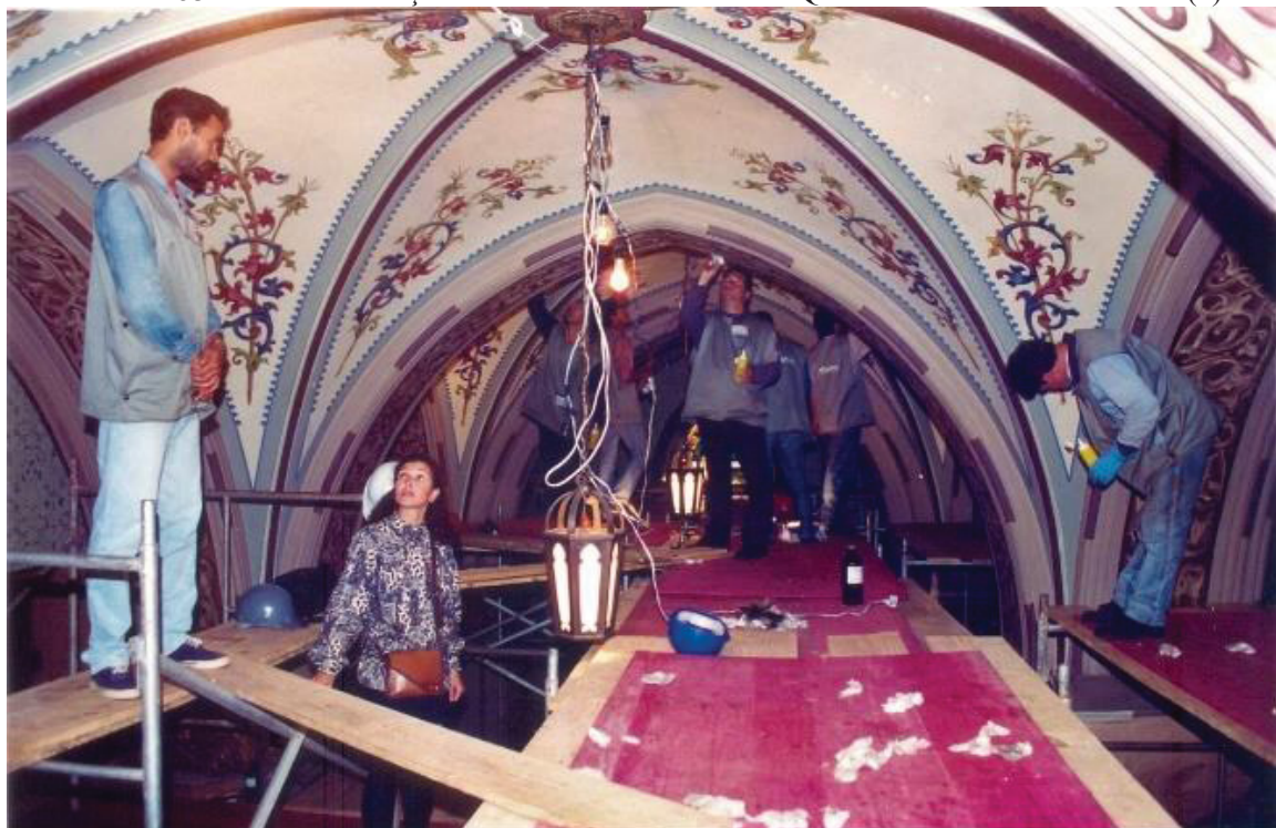
FIGURA 53 – REINTEGRAÇÃO DE PINTURAS NO ESTUQUE DAS NAVES LATERAIS (2)
