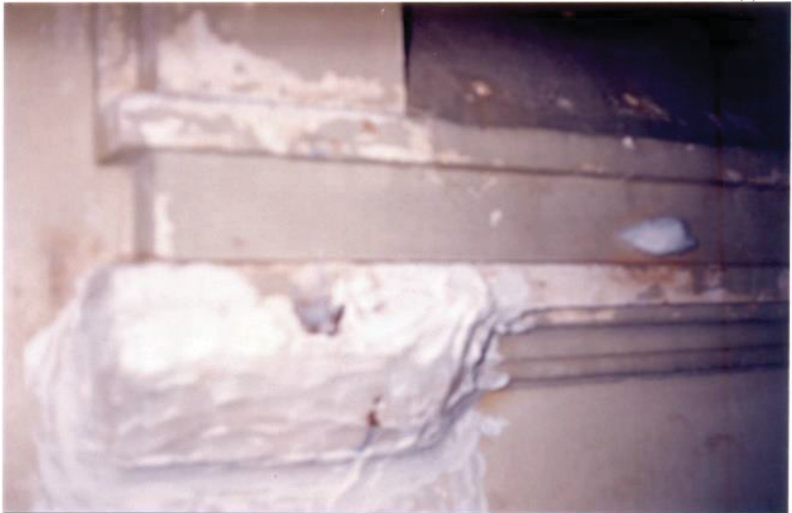
FIGURA 25 – MOLDES PARA ELEMENTOS DECORATIVOS DA FACHADA EXTERNA (4)
