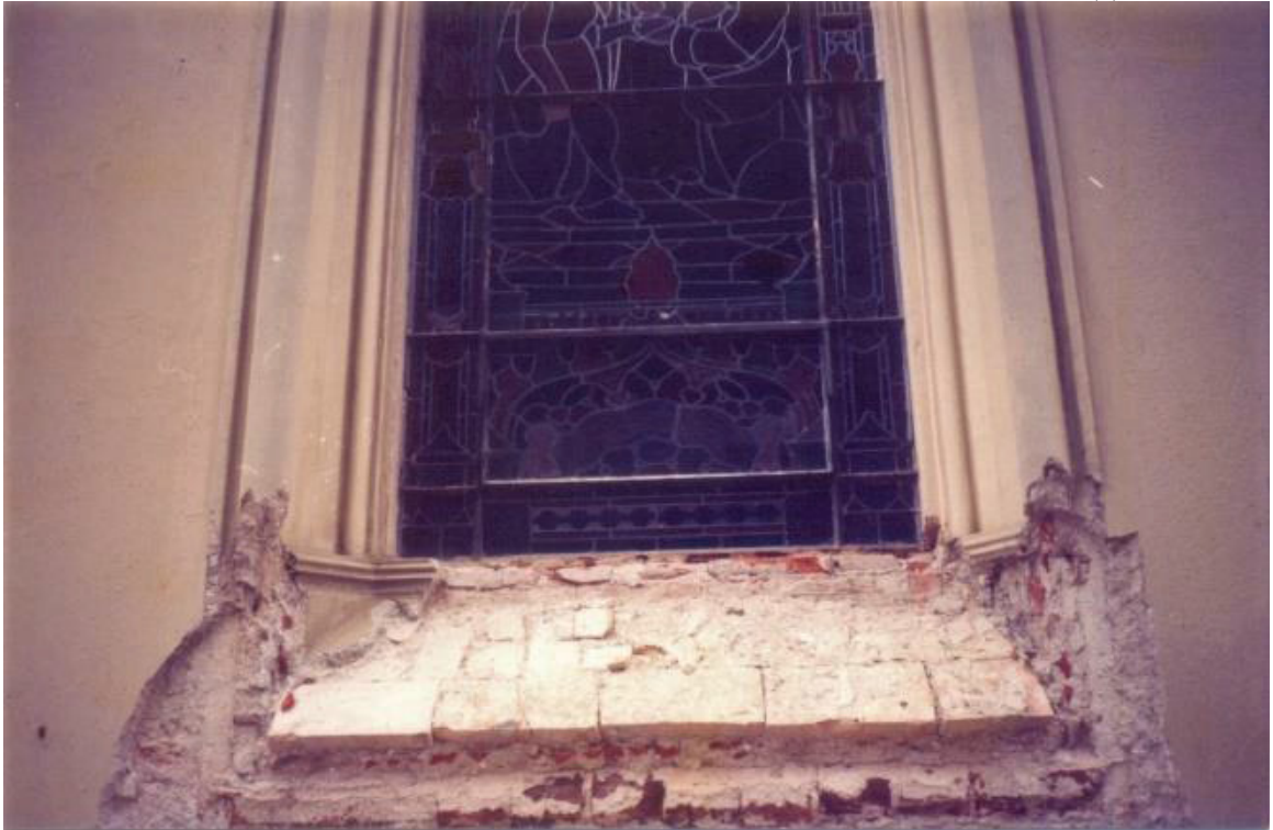
FIGURA 12 – DETALHE DA FACHADA LATERAL DIREITA DA IGREJA (1)
