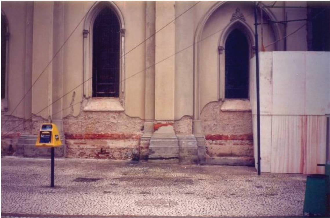
FIGURA 11 – FACHADA LATERAL DIREITA DA IGREJA
