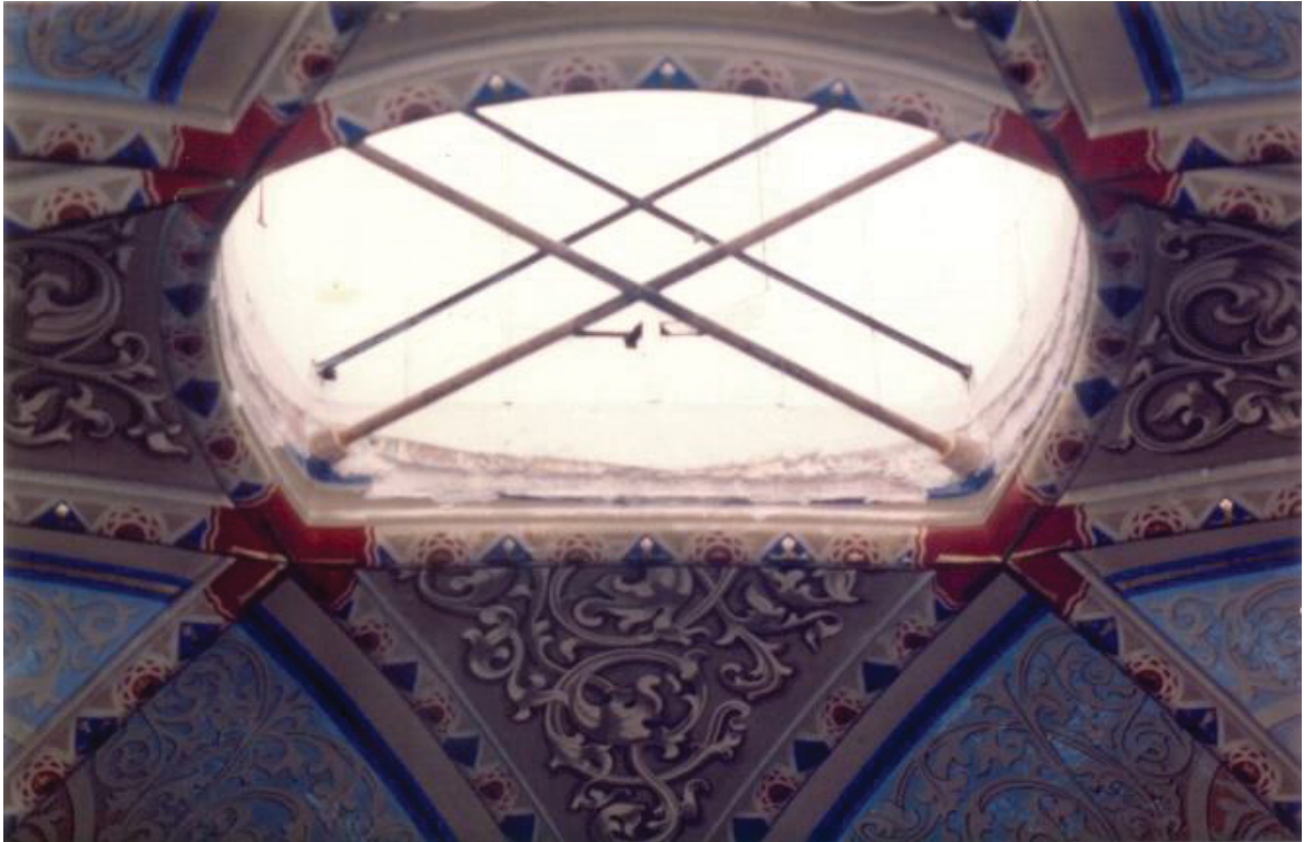
FIGURA 47 – ÓCULO DO LANTERNIM DESOBSTRUÍDO (1)
