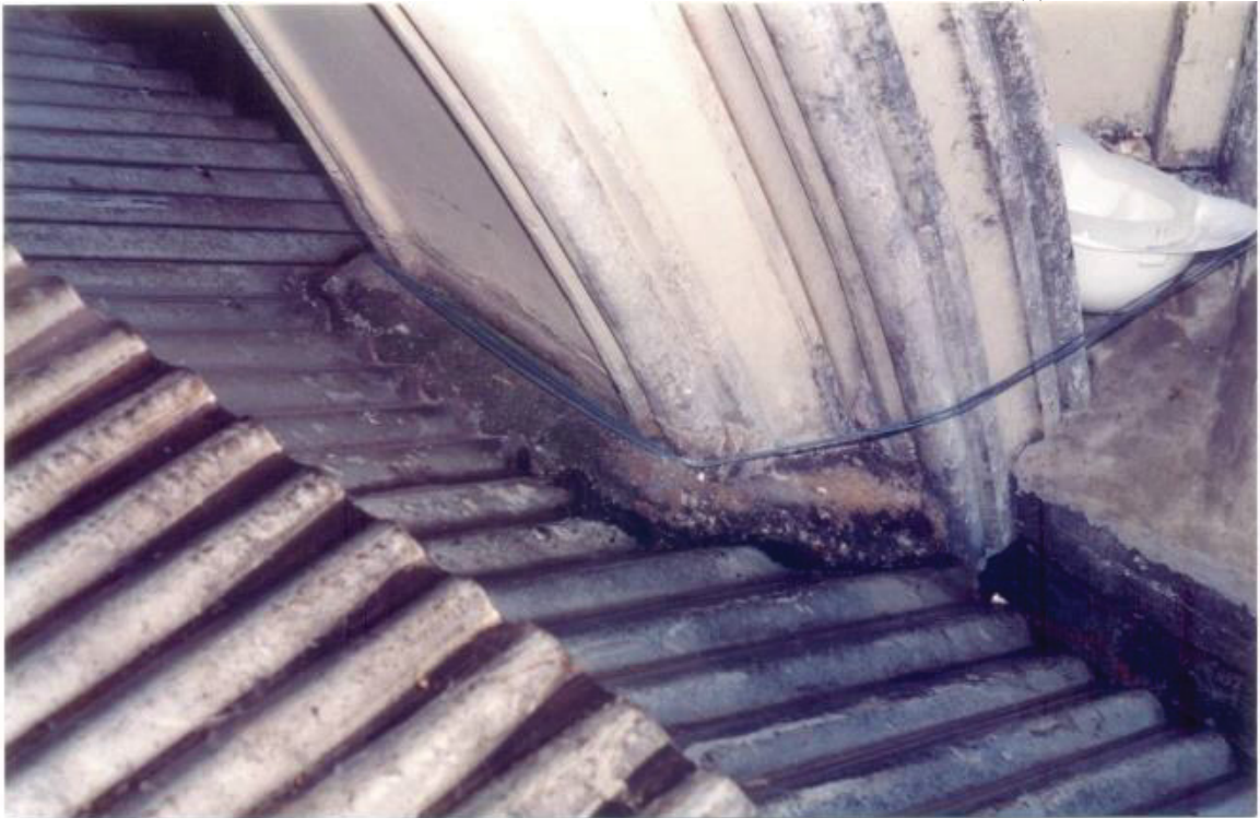
FIGURA 28 – TELHADO SOBRE AS SALAS DO CONSISTÓRIO (2)
