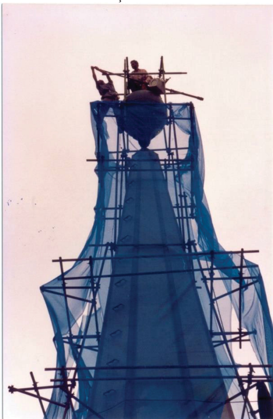
FIGURA 89 – RECOLOCAÇÃO DE ROSA-DOS-VENTOS (1)
