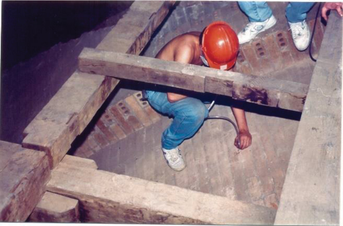
FIGURA 54 – PREENCHIMENTO DE RACHADURAS NA ABÓBADA CENTRAL (1)
