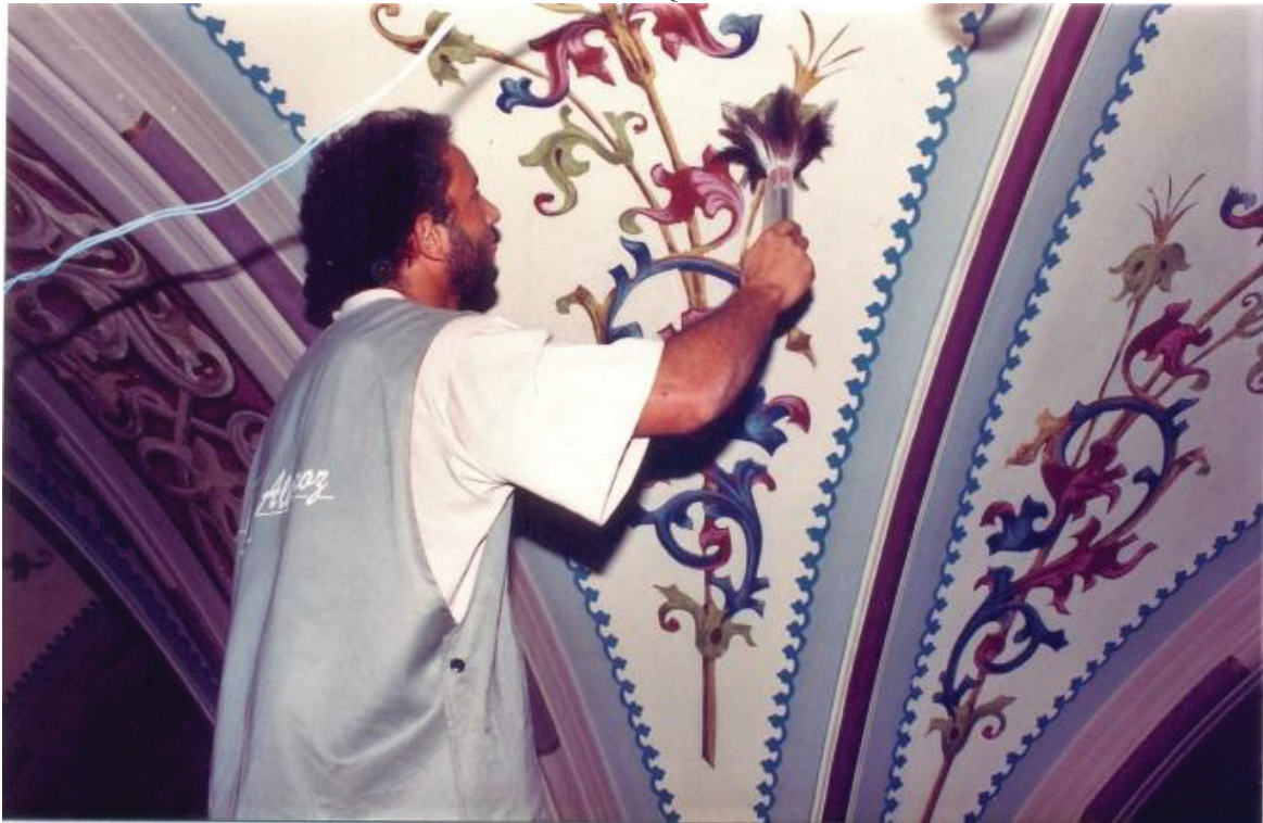
FIGURA 36 – LIMPEZA DO ESTUQUE DAS NAVES LATERAIS
