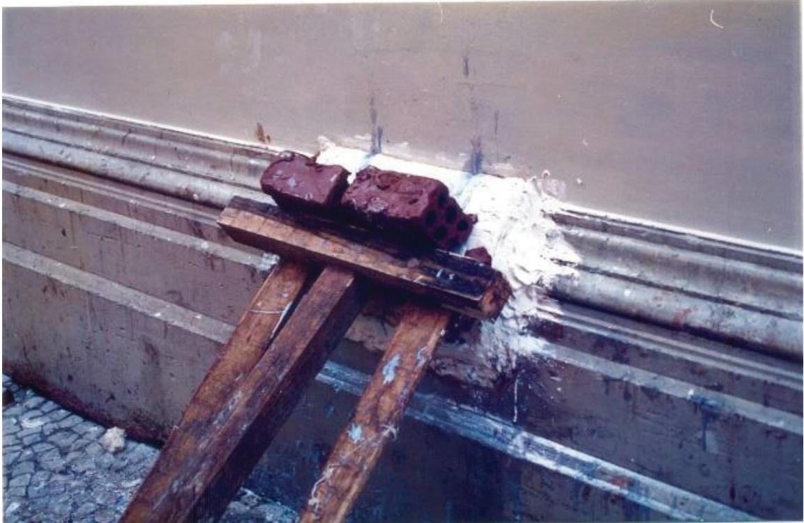
FIGURA 14 – MOLDE PARA ELEMENTO ESCALONADO NO BARRADO DA IGREJA (1)
