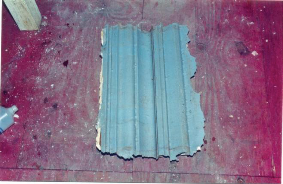
FIGURA 18 – MOLDE PARA ELEMENTO ESCALONADO NO BARRADO DA IGREJA (5)
