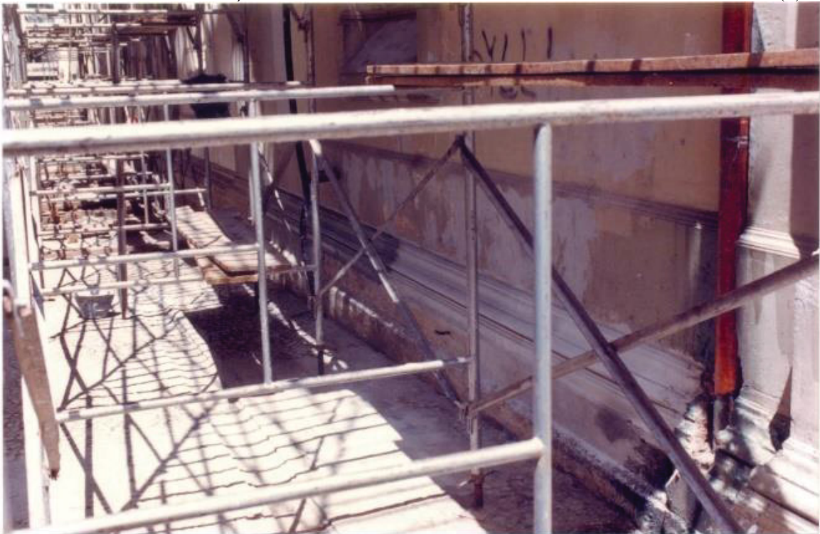
FIGURA 21 – RECUPERAÇÃO DE ELEMENTO ESCALONADO NO BARRADO DA IGREJA (3)
