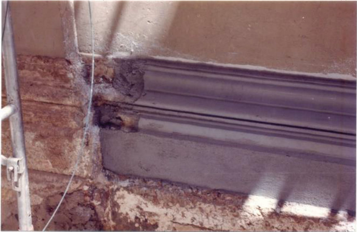
FIGURA 20 – RECUPERAÇÃO DE ELEMENTO ESCALONADO NO BARRADO DA IGREJA (2)
