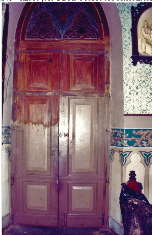
FIGURA 73 – REMOÇÃO DE PINTURA NA PORTA LATERAL (1)
