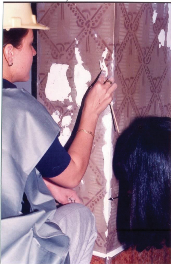
FIGURA 68 – RECOMPOSIÇÃO DO BARRADO DA CAPELA-MOR
