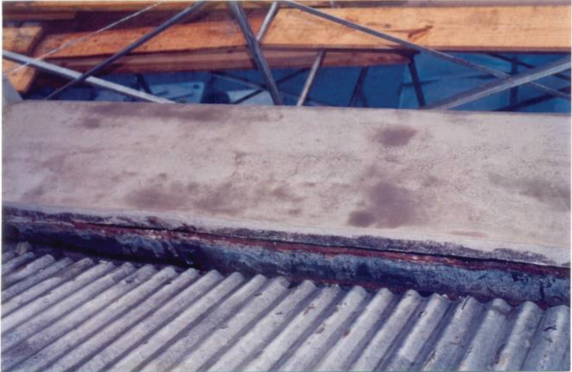
FIGURA 30 – CALHA SOBRE AS SALAS DO CONSISTÓRIO (2)
