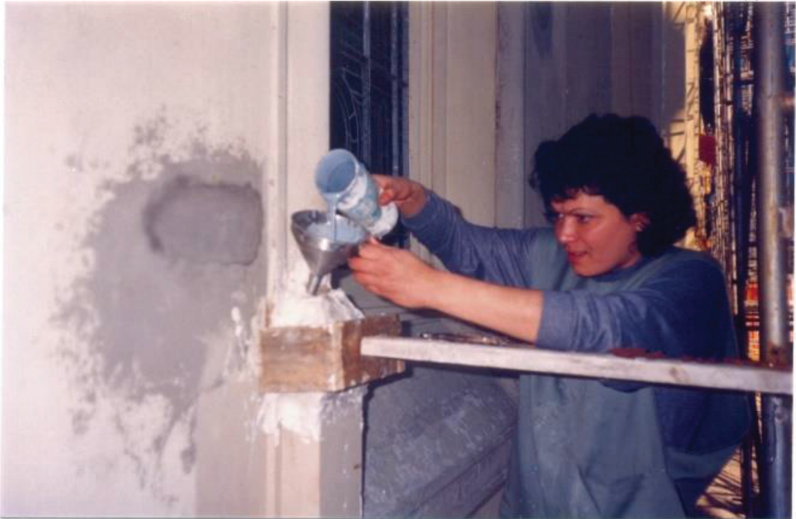
FIGURA 24 – MOLDES PARA ELEMENTOS DECORATIVOS DA FACHADA EXTERNA (3)
