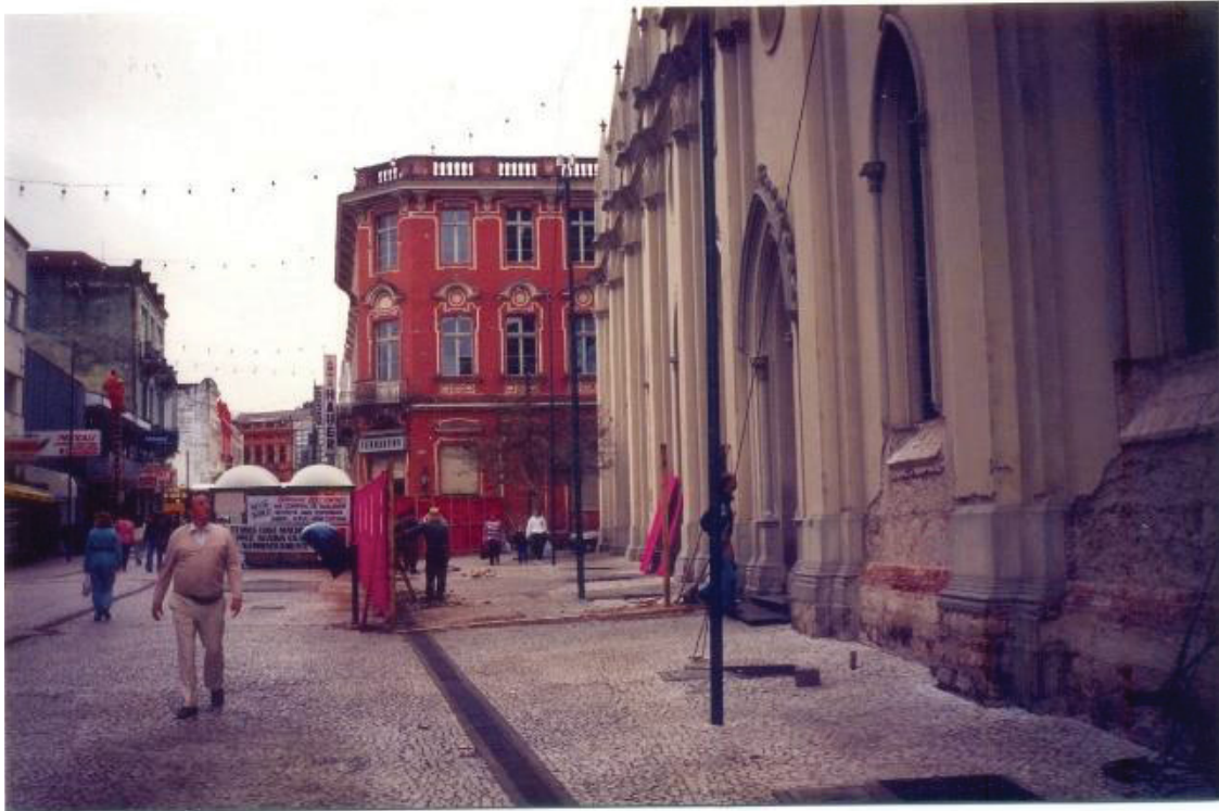
FIGURA 10 – MONTAGEM DE TAPUMES NA LATERAL DIREITA DA IGREJA
