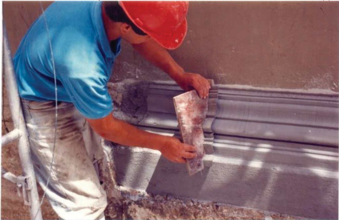
FIGURA 19 – RECUPERAÇÃO DE ELEMENTO ESCALONADO NO BARRADO DA IGREJA (1)
