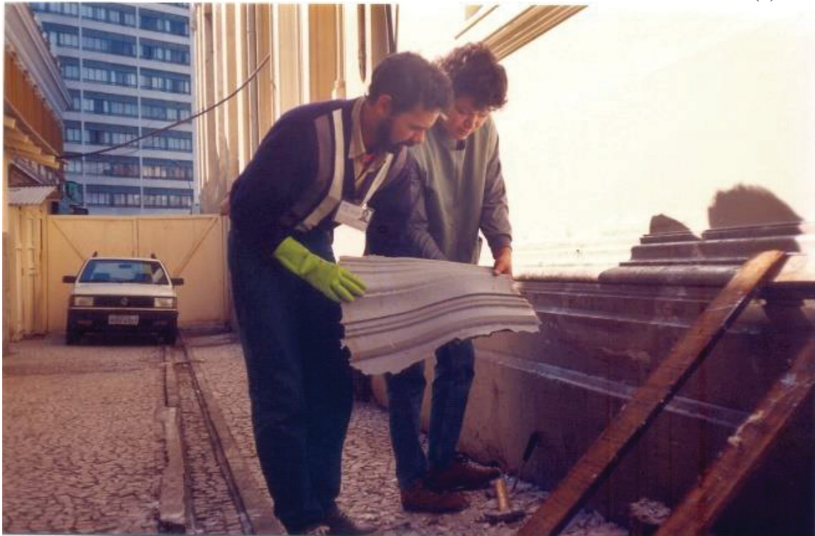
FIGURA 17 – MOLDE PARA ELEMENTO ESCALONADO NO BARRADO DA IGREJA (4)
