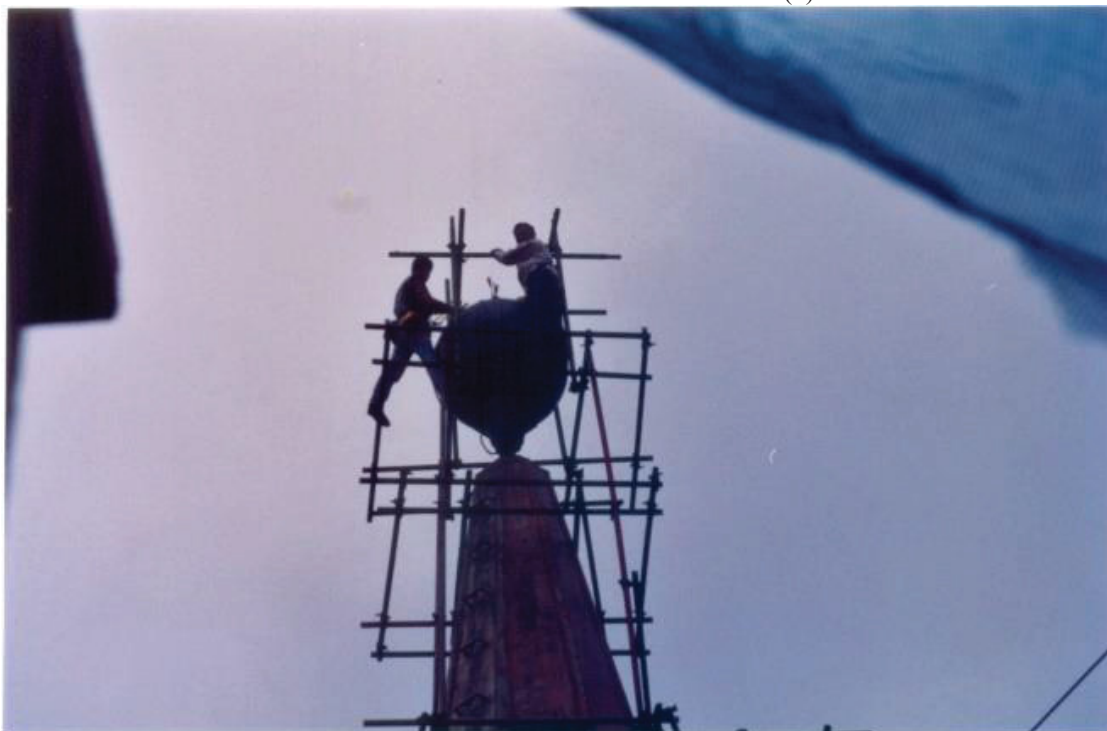
FIGURA 83 – ANDAIMES NAS TORRES (2)
