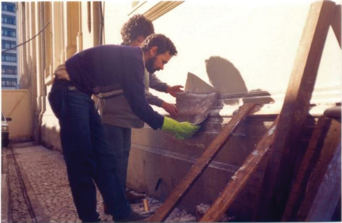
FIGURA 16 – MOLDE PARA ELEMENTO ESCALONADO NO BARRADO DA IGREJA (3)
