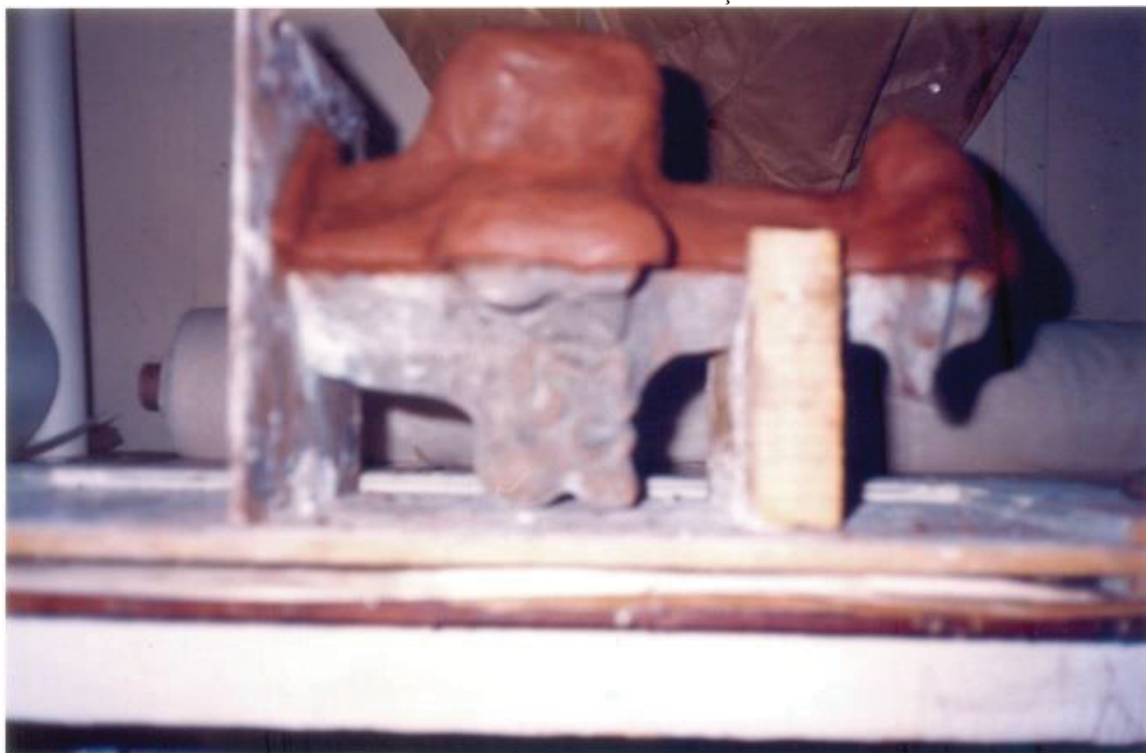
FIGURA 76 – MOLDE PARA RECOMPOSIÇÃO DE FLORÃO
