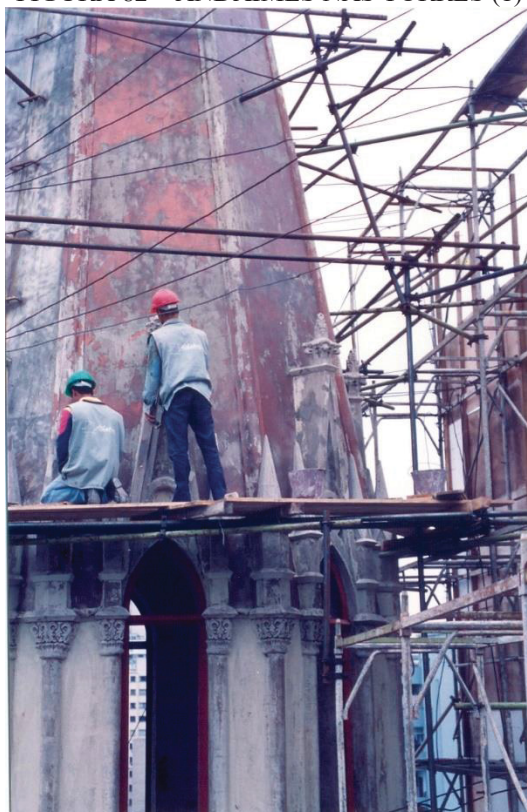
FIGURA 82 – ANDAIMES NAS TORRES (1)
