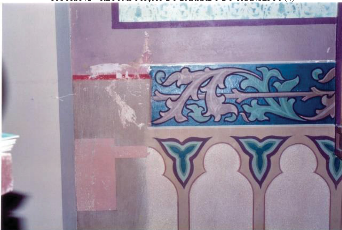
FIGURA 72 – RECOMPOSIÇÃO DO BARRADO DO TRANSEPTO (4)
