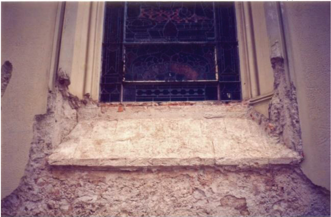
FIGURA 13 – DETALHE DA FACHADA LATERAL DIREITA DA IGREJA (2)
