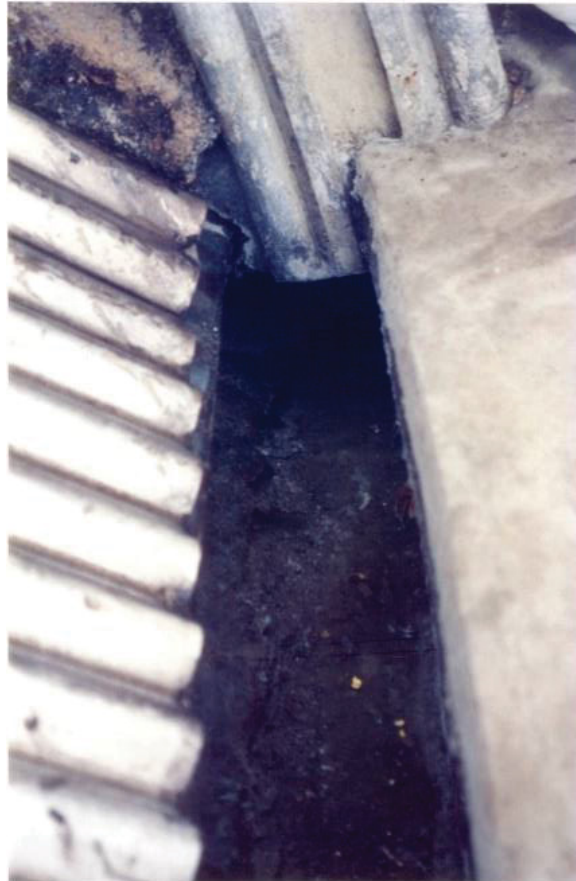
FIGURA 29 – CALHA SOBRE AS SALAS DO CONSISTÓRIO (1)
