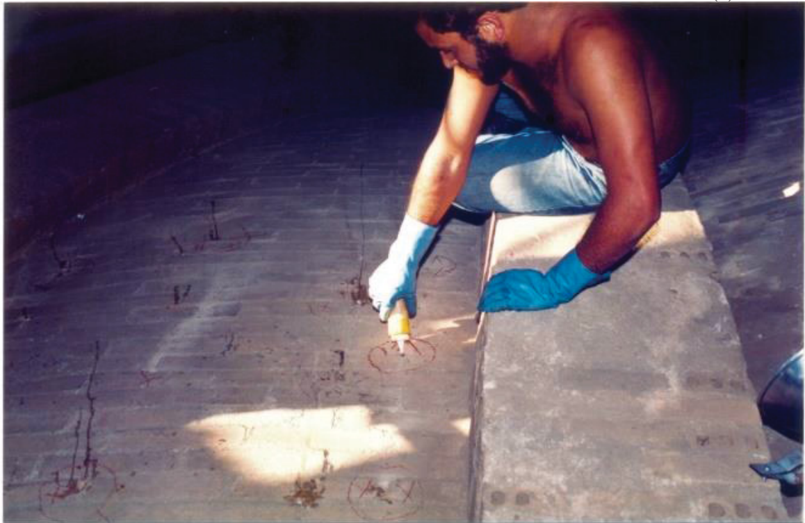
FIGURA 55 – PREENCHIMENTO DE RACHADURAS NA ABÓBADA CENTRAL (2)
