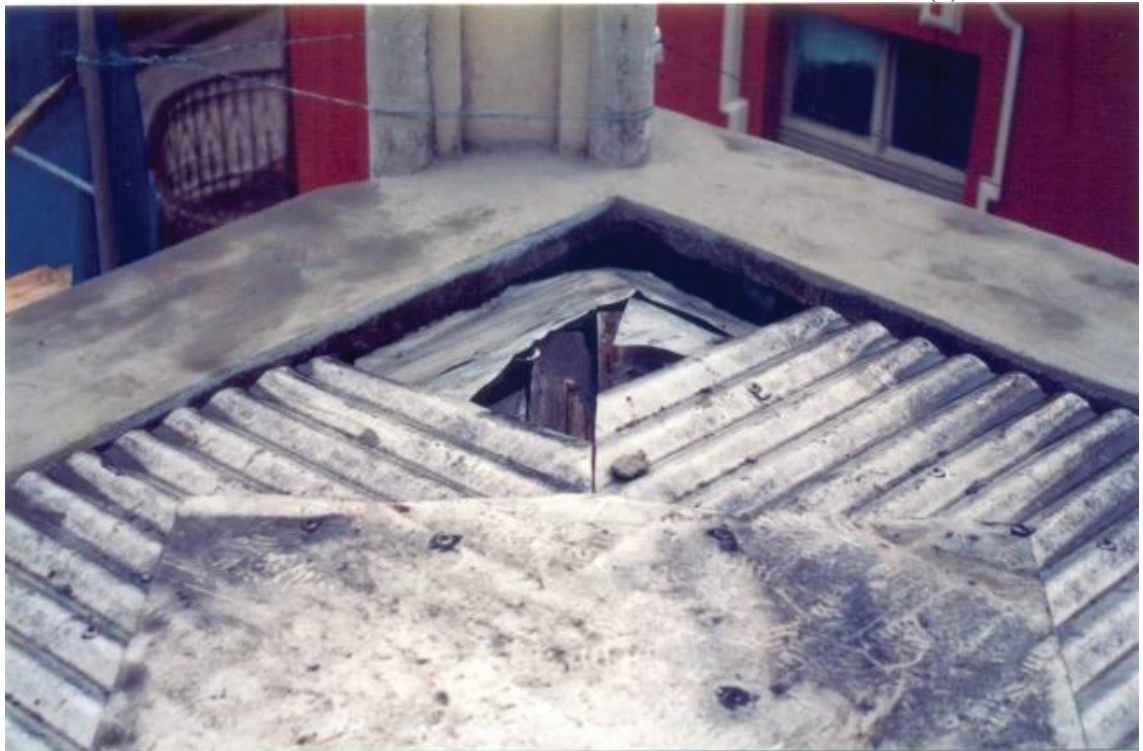
FIGURA 27 – TELHADO SOBRE AS SALAS DO CONSISTÓRIO (1)
