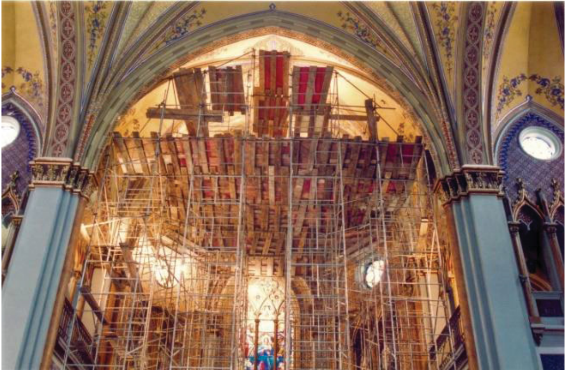
FIGURA 58 – ANDAIMES NA CAPELA-MOR (2)
