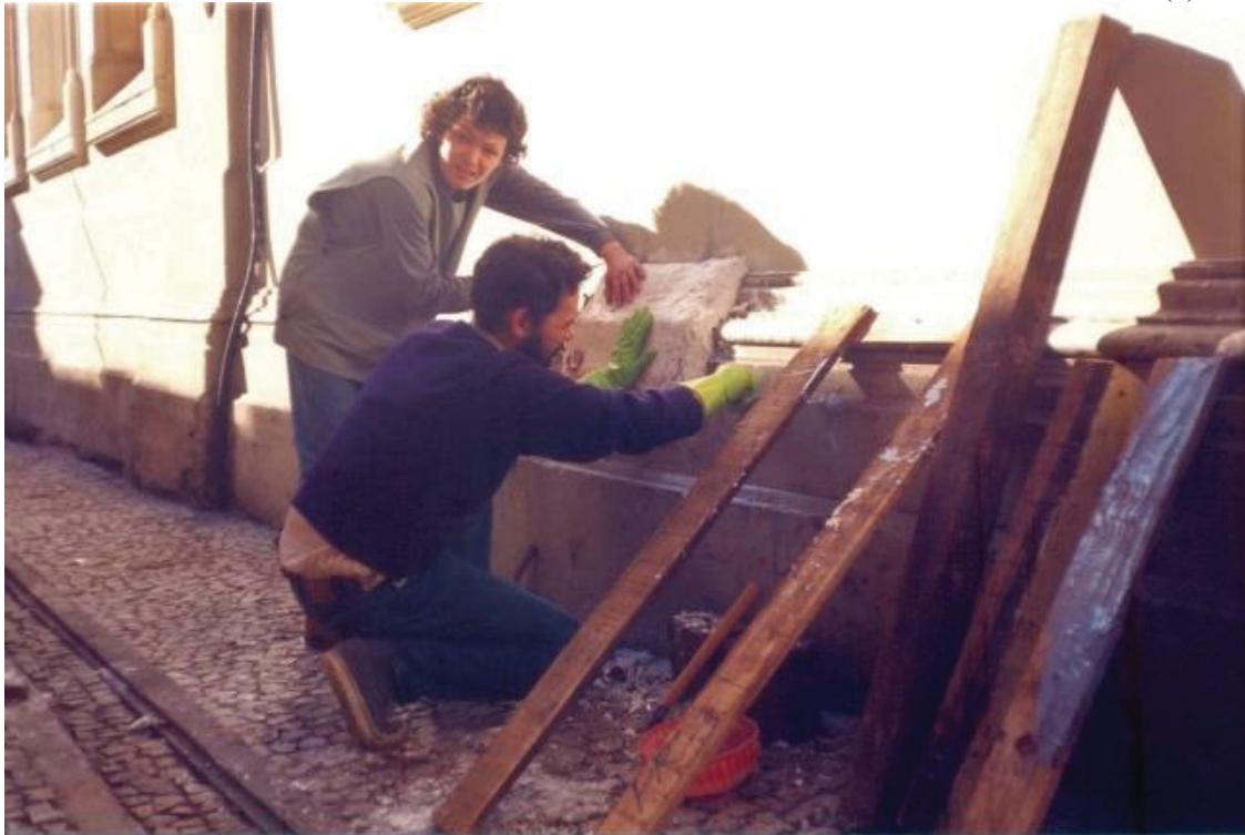
FIGURA 15 – MOLDE PARA ELEMENTO ESCALONADO NO BARRADO DA IGREJA (2)
