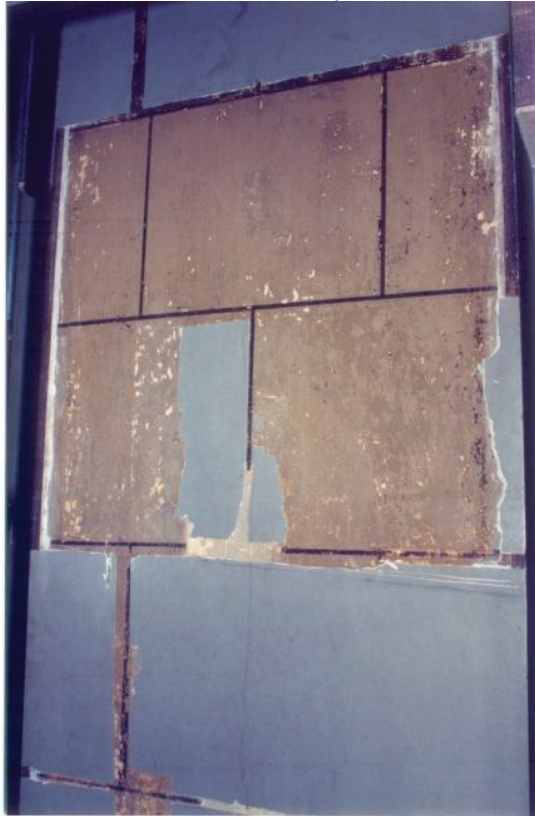
FIGURA 32 – JANELAS DE PROSPECÇÃO ESTRATIGRÁFICA (2)
