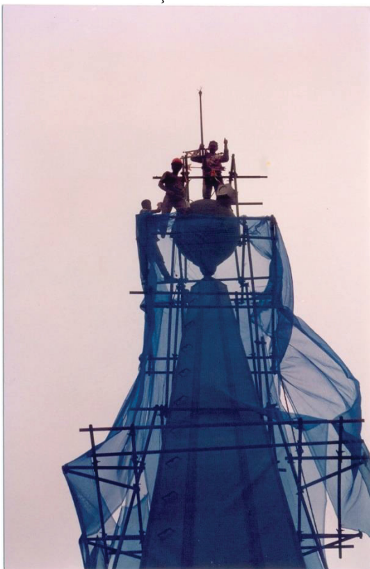
FIGURA 90 – RECOLOCAÇÃO DE ROSA-DOS-VENTOS (2)
