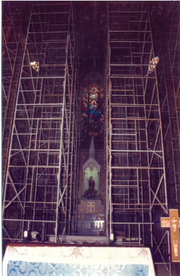
FIGURA 57 – ANDAIMES NA CAPELA-MOR (1)
