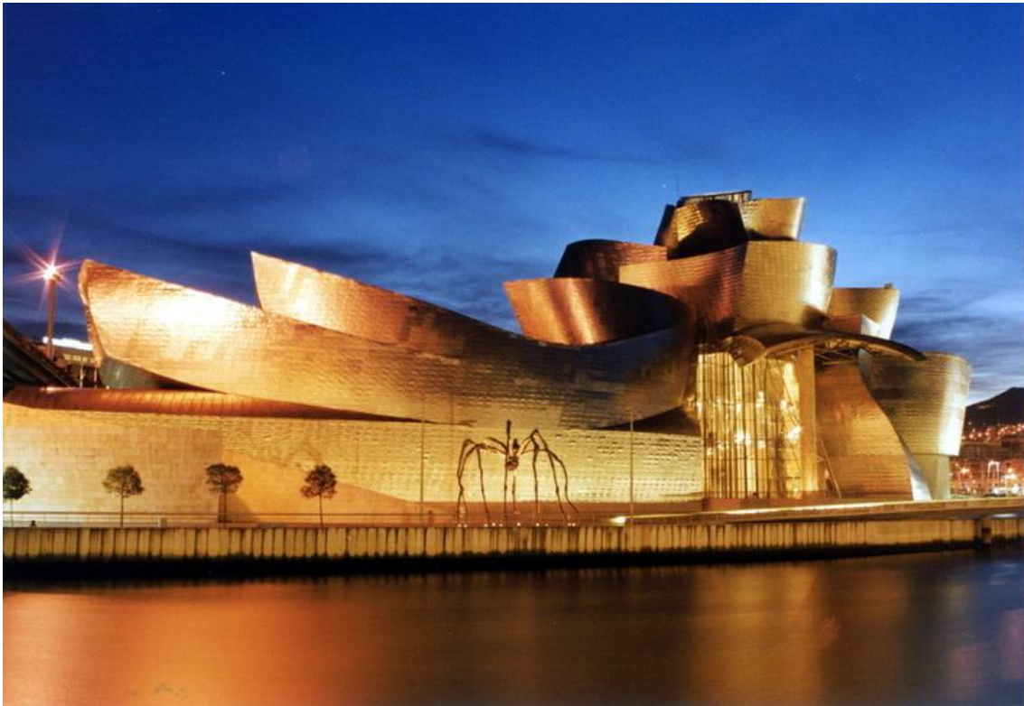
FIGURA 2 – ARQUITETURA ORGÂNICA DO MUSEU GUGGENHEIN DE BILBAO.
