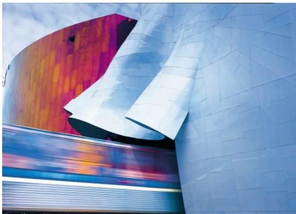
FIGURA 24 – PLACAS METÁLICAS EM DETALHE E PASSAGEM DO MONOTRILHO POR DENTRO DO MUSEU.
