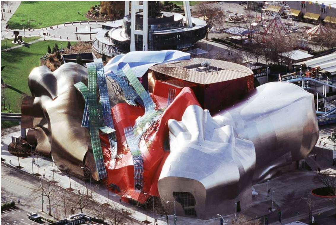
FIGURA 25 – VISTA AÉREA DA FACHADA LESTE.
