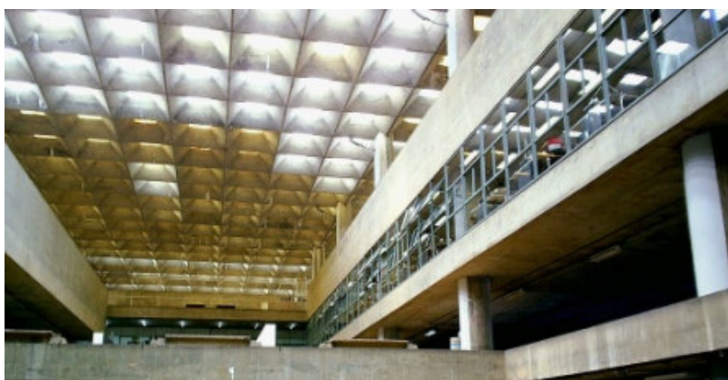
Ilustração 29 - Vista da cobertura a partir do “fosso”, ou acesso ao auditório
