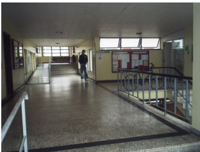
Ilustração 7 - Corredor central - 2º pavimento
