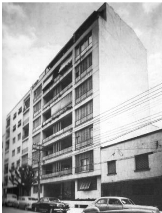
Ilustração 48 - Fachada do edifício sede da Escola da Cidade, a partir da rua Fonte: Livro Oswaldo Arthur Bratke, Pro Editores, p. 197
