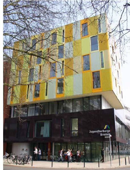
Figura 4.5.: Lateral oeste (Fonte: Raumzeit, 2011)
