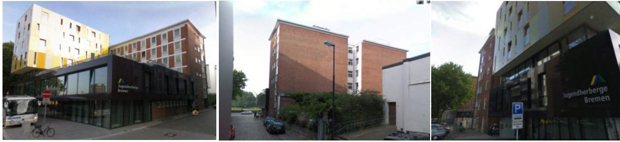
Figura 4.7.: Vistas externas (Fonte: Google Earth, 2011)
