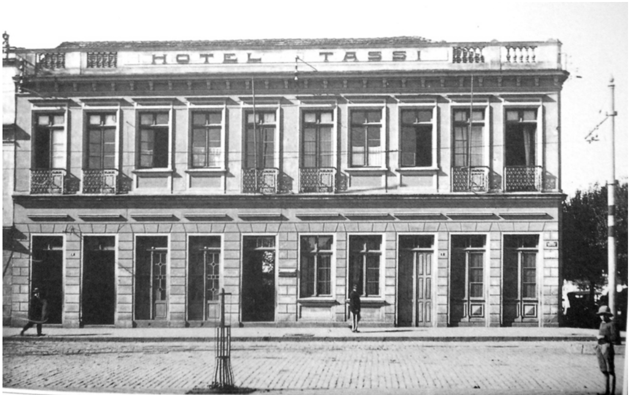
Figura 5.15.: Edifício em estilo eclético (Fonte: Teixeira, 1991)
