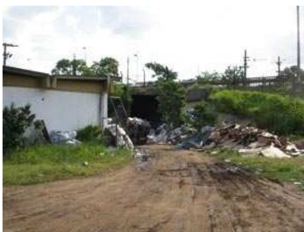
FIGURA 3 - Espaço de convívio e moradia à esquerda, e entrada do túnel, ao fundo.
