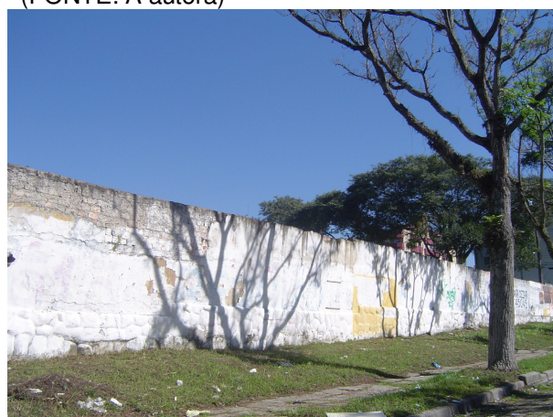
Fig. 4.20 – Muros altos cercando o terreno (FONTE: A autora)
