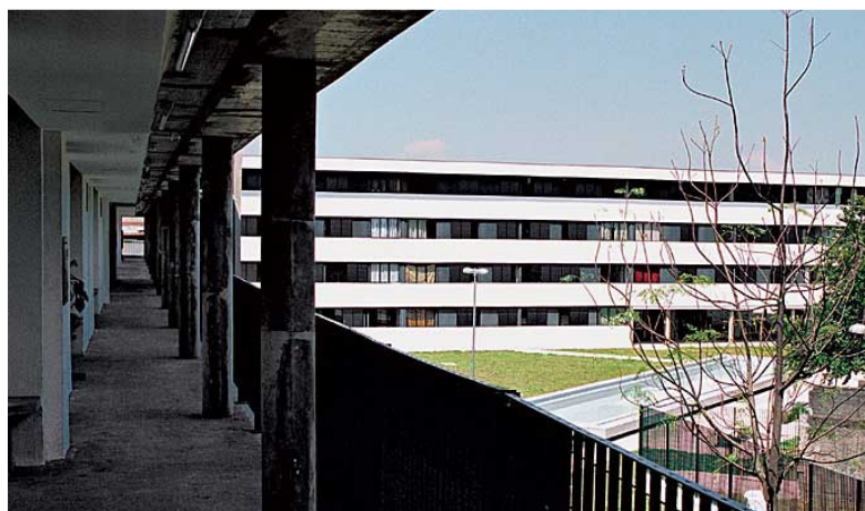
Fig. 3.33 – Fachada - Ala externa (FONTE: VIGLIECCA, 2009)
