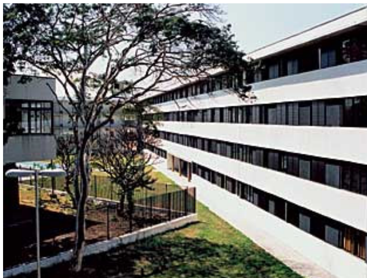
Fig. 3.32 – Edifício à esquerda, biblioteca à direita (FONTE: ARCOWEB, 2009)
