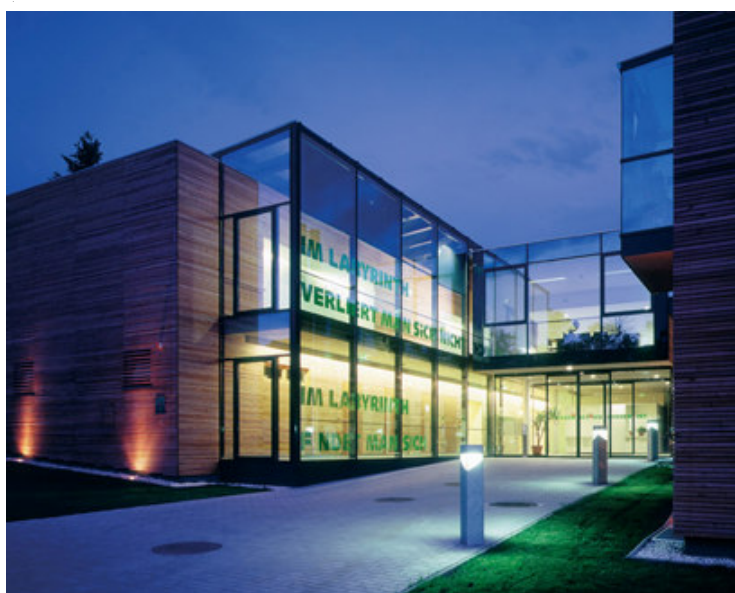
Fig. 3.11 – Acesso principal (FONTE:KADAWITTFELDARCHITEKTUR, 2009a)
