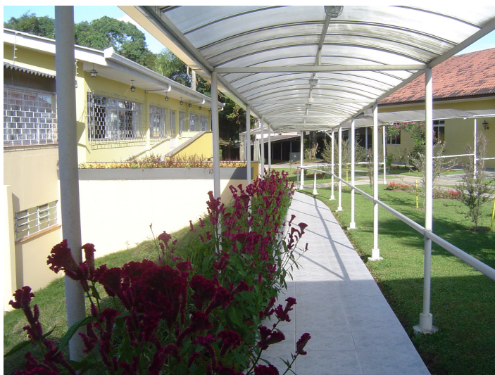
Fig. 3.46 – Circulação externa coberta (FONTE: A Autora)
