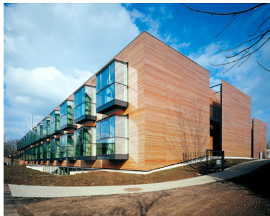
Fig. 3.23 – Fachada lateral e posterior (FONTE:KADAWITTFELDARCHITEKTUR, 2009b)
