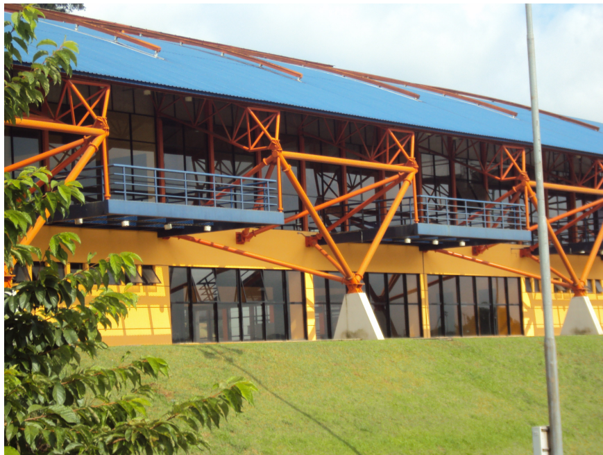
FIGURA 45 – Vista externa da piscina coberta, mostra como funciona a estrutura da cobertura, Universidade Positivo. Disponível em: acervo do autor
