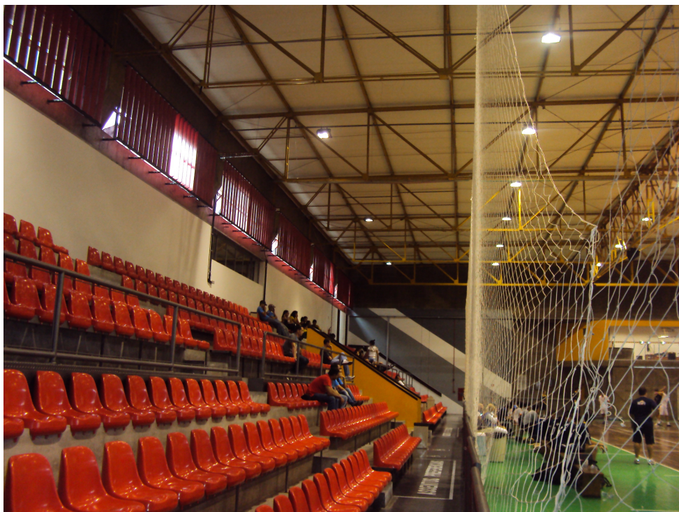
FIGURA 41 – Vista interna do ginásio poliesportivo da Pontifícia Universidade Católica em Curitiba, arquibancadas e detalhando a estrutura e os brises. Disponível em: acervo do autor
