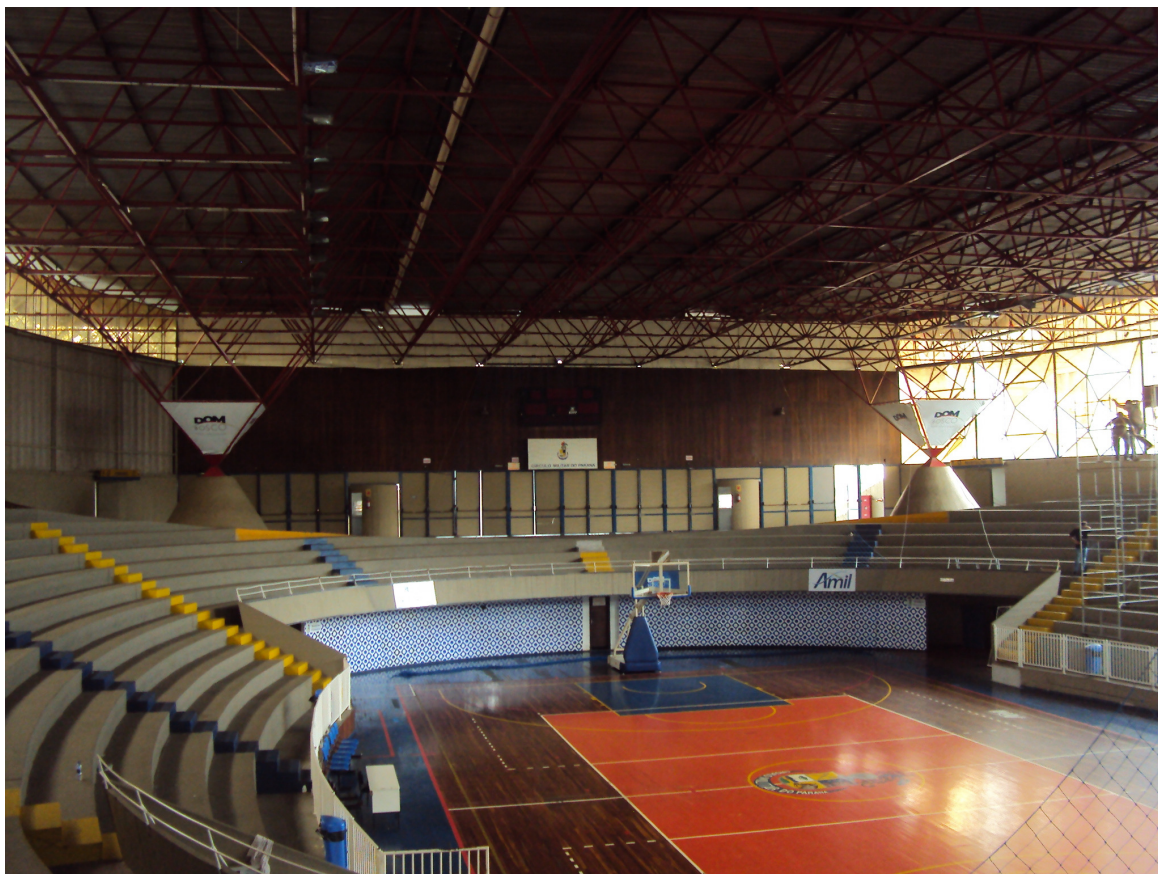
FIGURA 57 – Vista interna do ginásio do Circulo Militar do Paraná, mostra dois dos quatro apoios da cobertura em treliça espacial. Disponível em: acervo do autor
