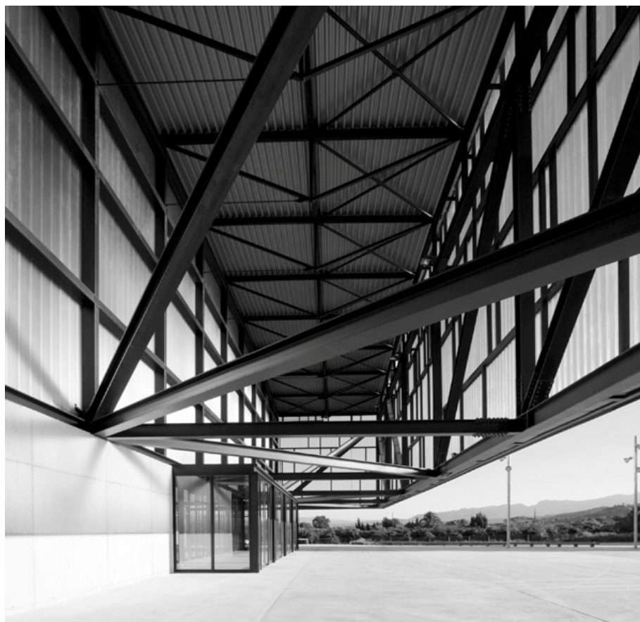
FIGURA 23 – Vista externa do Pavilhão mostrando a estrutura em balanço. Disponível em:< http://mariocorea.com/obras/deportiva/pabellon-ferial-y-deportivo/
