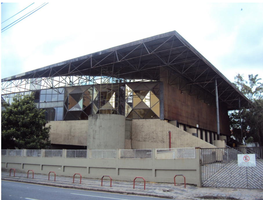
FIGURA 37 – Vista externa do ginásio do Circulo Militar do Paraná, mostra os fechamentos e cobertura em treliça espacial que se prolonga em balanço. Disponível em: acervo do autor
