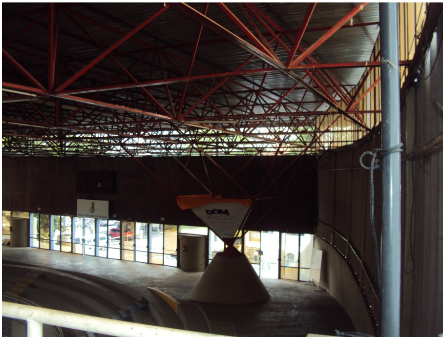
FIGURA 36 – Vista interna do ginásio do Circulo Militar do Paraná, mostra um dos apoios da cobertura em treliça espacial. Disponível em: acervo do autor
