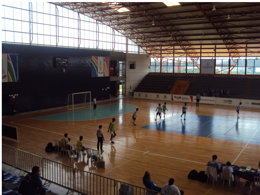
FIGURA 47 – Vista interna do Ginásio Poliesportivo mostra iluminação natural grande quantidade de luz vinda do lado de fora, fachada norte. Disponível em: acervo do autor
