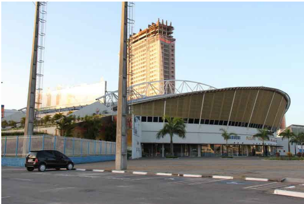
FIGURA 12 – Vista externa que mostra bem a como ficou a forma do ginásio e também a estrutura. Disponível em: < http://www.jornalcomunicacao.com/MaisAnuncio.asp?CodProduto=6510 >
