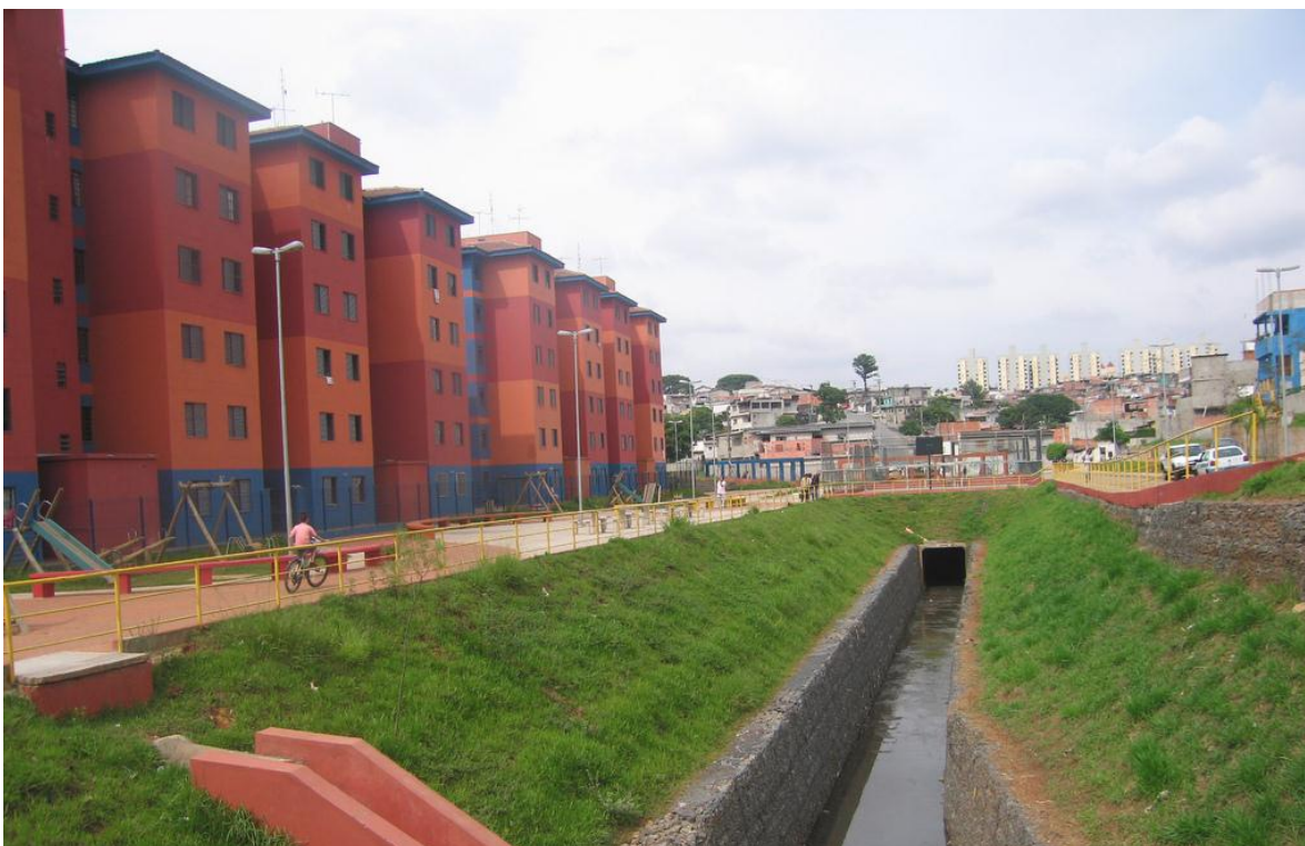
Figura 3.4: Córrego Cruzeiro do Sul após a intervenção urbana - 2008 Fonte: SABESP (2010)
