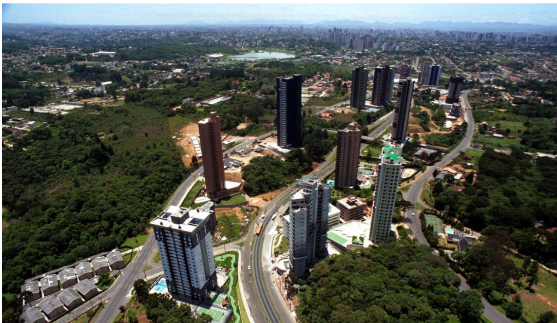
Figura 4.4: Vista aérea da Conectora 5 e dos edifícios do Ecoville - 2007 Fonte: IPPUC (2012)
