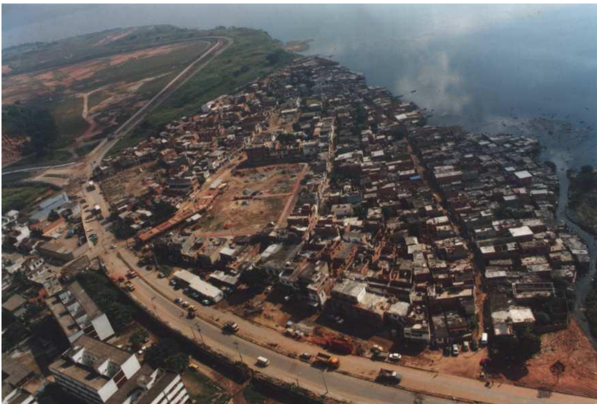
Figura 3.8: Vista área da Favela Parque Royal antes da intervenção Fonte: Archi 5, 1994 (apud MAGALHÃES, 2010)
