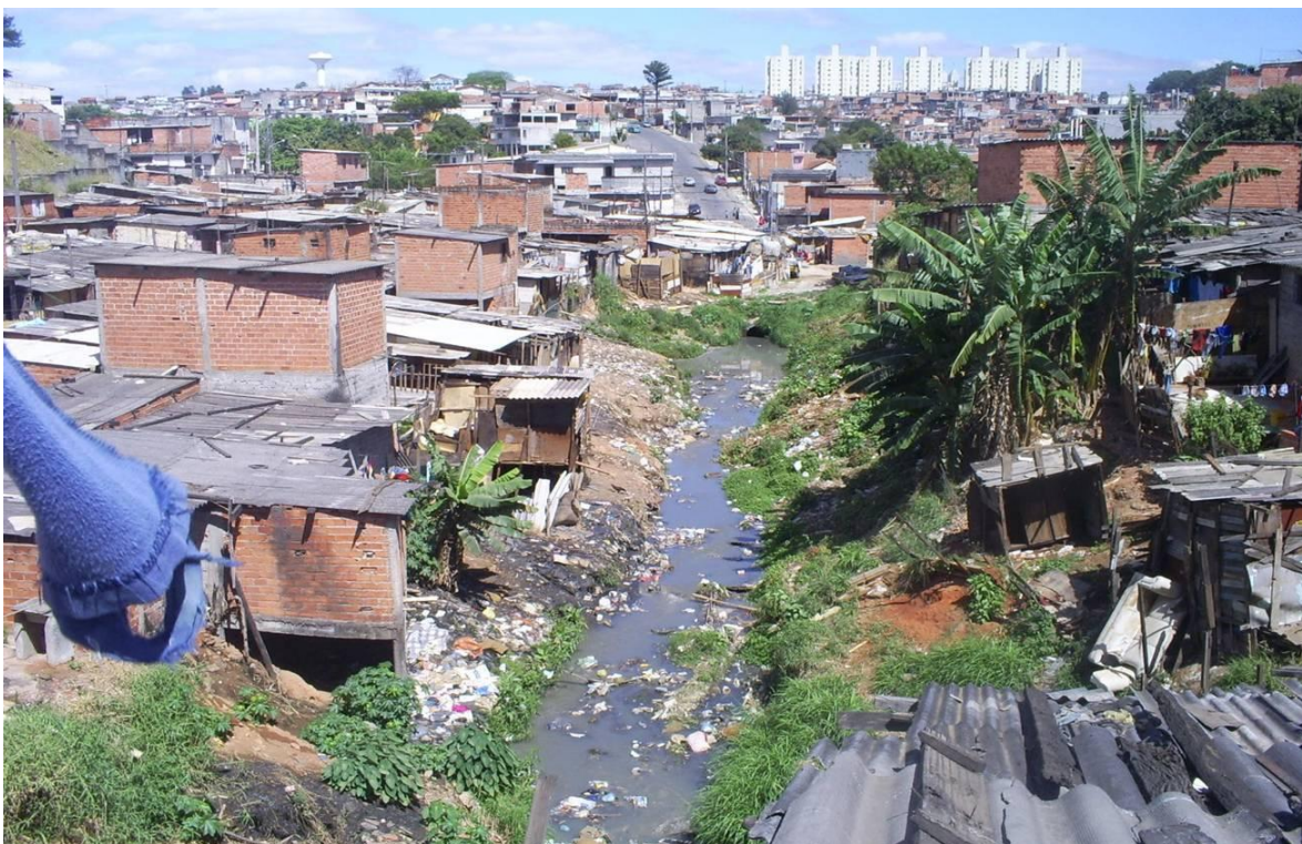
Figura 3.3: Córrego Cruzeiro do Sul antes da intervenção urbana - 2006 Fonte: SABESP (2008)
