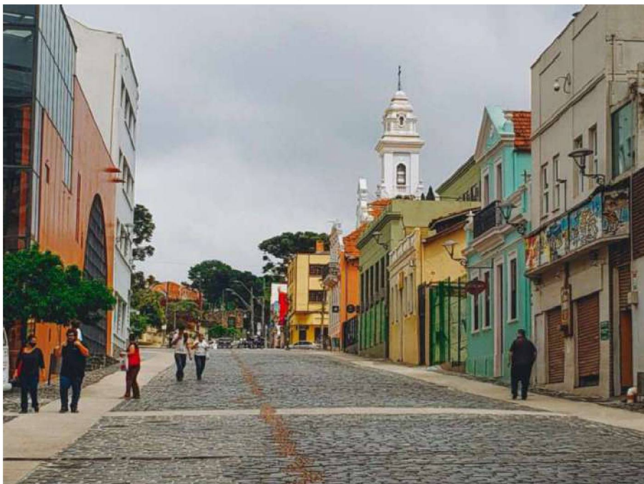
FIGURA 39: Na fotografia a Rua Dr. Claudino dos Santos, que dá acesso ao Largo da Ordem propriamente dito, com implantação de faixa de concreto de 1,5 metros de largura visando a acessibilidade e pintura das fachadas.
