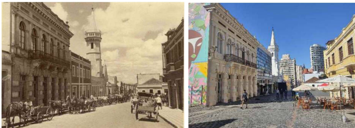
FIGURA 30: Os colonos e suas carroças no Largo na década de 1950; em primeiro plano o edifício à esquerda é a Casa Hoffmann; à direita uma parte da Casa de Rodolfo Strobel. Ao fundo a Igreja da Ordem já com a torre, e a Casa Romário Martins.
