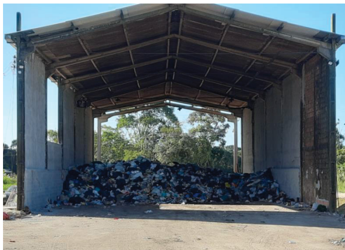
FIGURA 9 – Barracão do CIAS usado para o transbordo dos resíduos domiciliares
