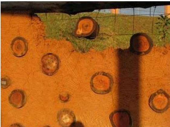
Fig. 3.2.9 – Parede de Cordwood em construção
