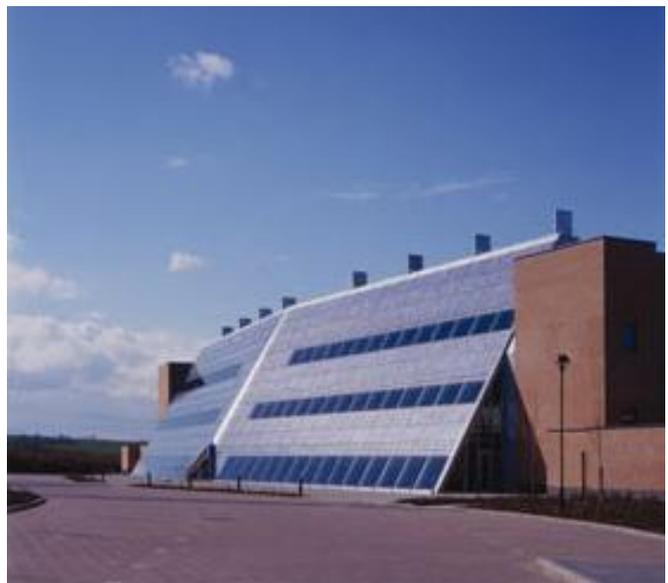
Fig. 2.3.15 – Painéis fotovoltaicos e sistema de aquecimento passivo no escritório de energia solar de Doxford, projetado por Studio e architects
