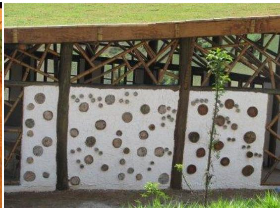
Fig. 3.2.10 – Parede de Cordwood finalizada
