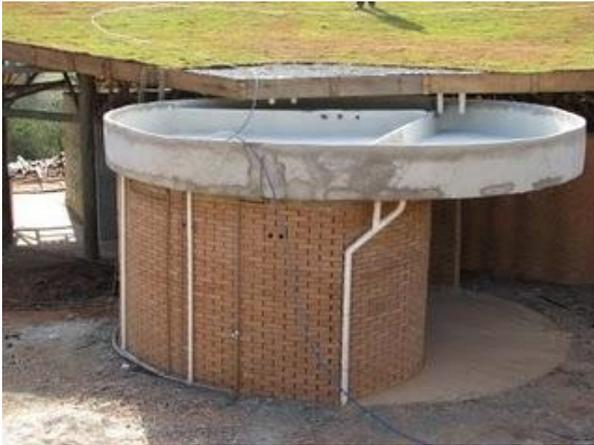
Fig. 3.2.5 – Teto verde e cisterna de captação
