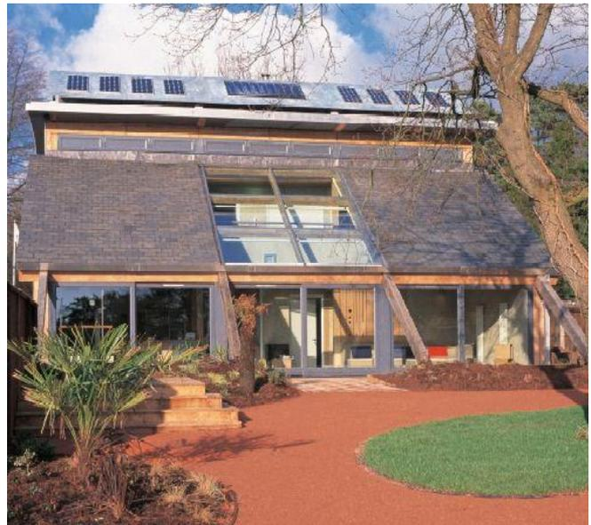
Fig. 2.3.13 – House for the future, projetada por Jestico e Whiles, utiliza energia solar passiva
