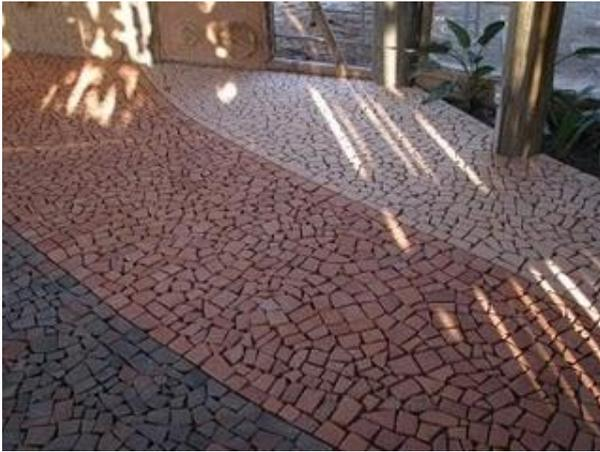
Fig. 3.2.11 – Restos de cerâmica utilizados no piso
