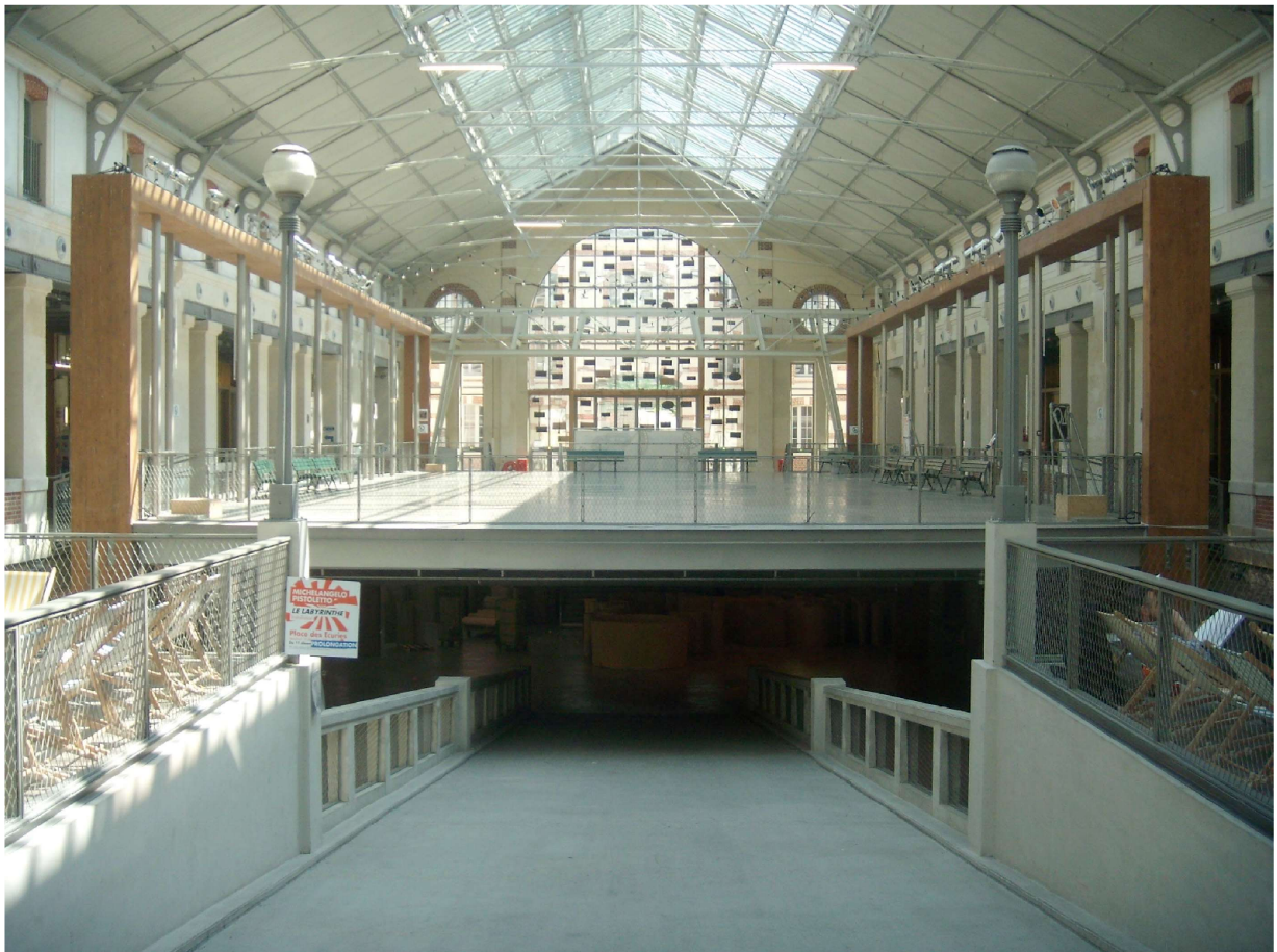
Figura 34: Nave central. 104. Paris.
