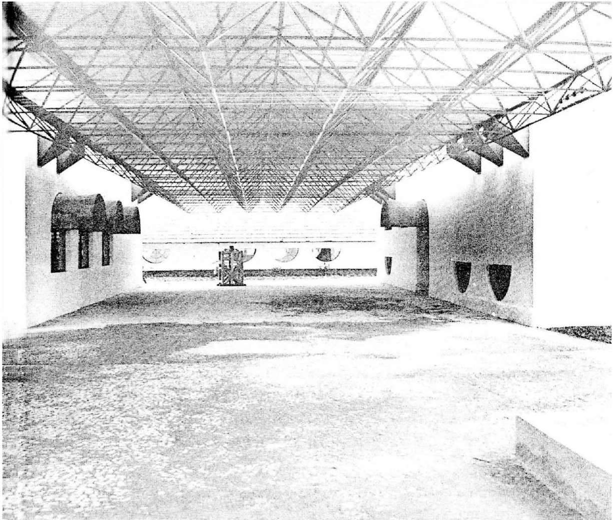
Figura 46: vista interna do pátio. Fonte: Fundação Cultural de Curitiba, FCC.
