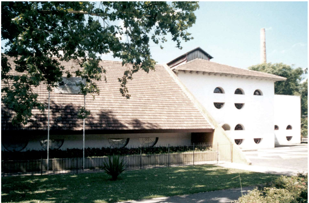
Figura 45: Vista externa do Centro de Criatividade. Fonte: Fundação Cultural de Curitiba, FCC.
