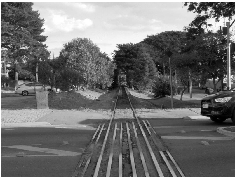
FIGURA 70 – CRUZAMENTO ENTRE A FERROVIA E A RUA AUGUSTO STRESSER FONTE: Autor (2015)
