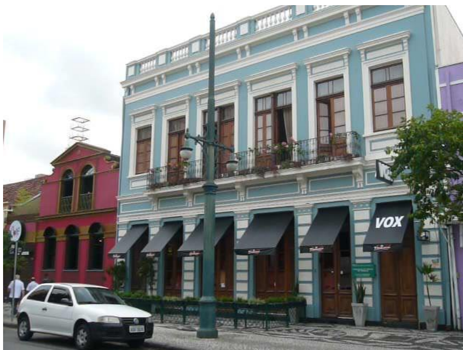
Figura 5.2.18 – Vista atual das edificações históricas da Rua Barão do Rio Branco que se tornaram o Restaurante Coré (prédio vermelho) e o Bar Vox (prédio azul). (AUTORA, 2015)
