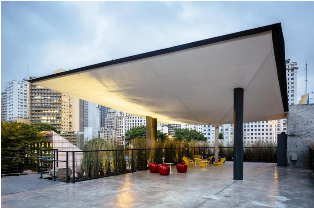
Figura 4.2.17 – Vista geral da cobertura metálica do terraço do Centro Cultural Red Bull Station . (ARCHDAILY, 2013)
