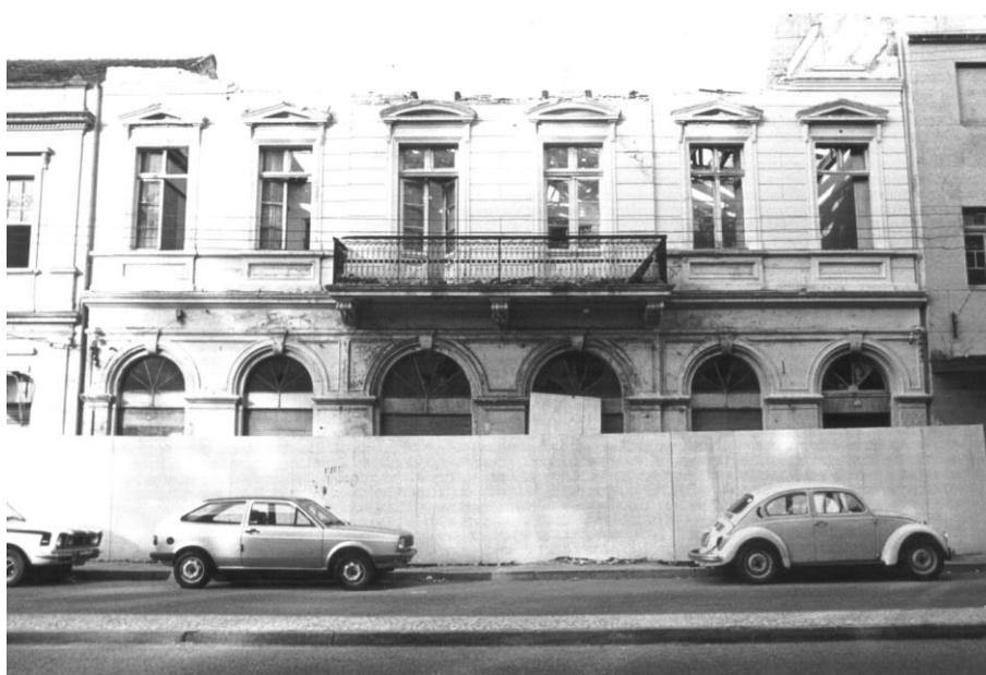
Figura 5.3.12 – Vista do prédio número 773 da Rua Barão do Rio Branco, após o incêndio de 1986 que o destruiu parcialmente. (IPPUC, 2015)
