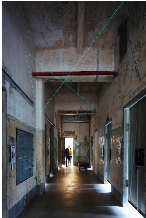
Figura 4.2.14 – Vista do corredor dos ateliês (portas metálicas do prédio original) do Centro Cultural Red Bull Station . (ARCHDAILY, 2013)
