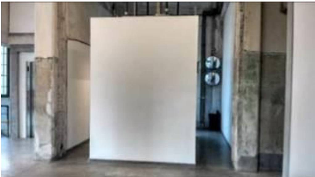
Figura 4.2.6 – Vista do sanitário em dry wall do Primeiro Pavimento do Centro Cultural Red Bull Station . (MENEZES, 2014)
