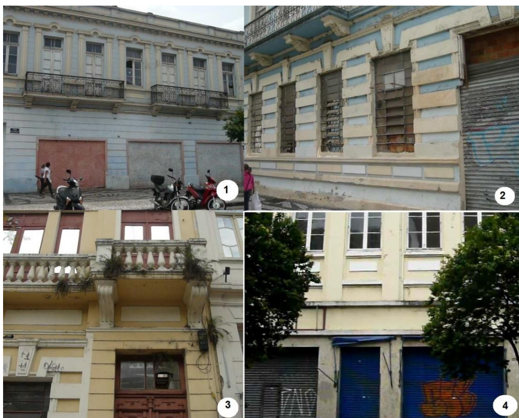
Figura 5.2.20 – Imagens que denunciam o estado atual de abandono das edificações históricas na Rua Barão do Rio Branco: Casa Coronel Agostinho Souza, fechada e desocupada (1), Edificação com alterações e abandonada; (2) Edificação em ruína e sem cobertura; e (4) Edificação com alterações e desocupada. (AUTORA, 2015)
