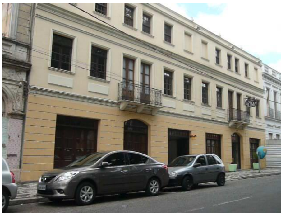
Figura 5.3.5 – Vista do prédio número 805 da Rua Barão do Rio Branco, onde funciona o Hostel Roma, antigo Hotel Roma de Curitiba. (AUTORA, 2015)
