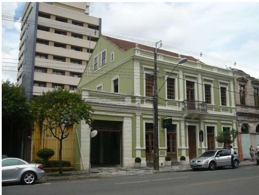
Figura 5.3.3 – Vista atual do prédio número 763 da Rua Barão do Rio Branco, que funciona como hall de entrada do condomínio LifeSpace Estação . (AUTORA, 2015)
