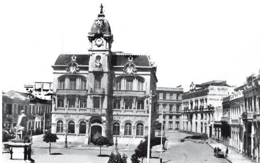
Figura 5.2.16 – Vista antiga do prédio eclético da Prefeitura de Curitiba, construído em 1916, durante a segunda gestão de Cândido de Abreu (1856-1919), na Praça Generoso Marques. (GAZETA DO POVO, 2015e)
