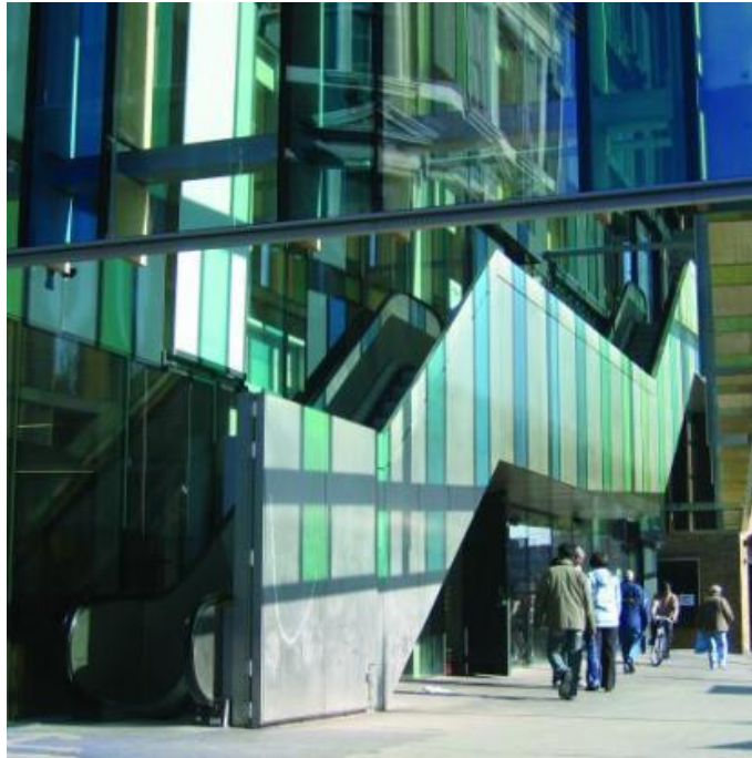
Figura 4.1.4 – Vista da escada rolante de acesso externo da Idea Store Whitechapel (PHAIDON ATLAS, 2015)
