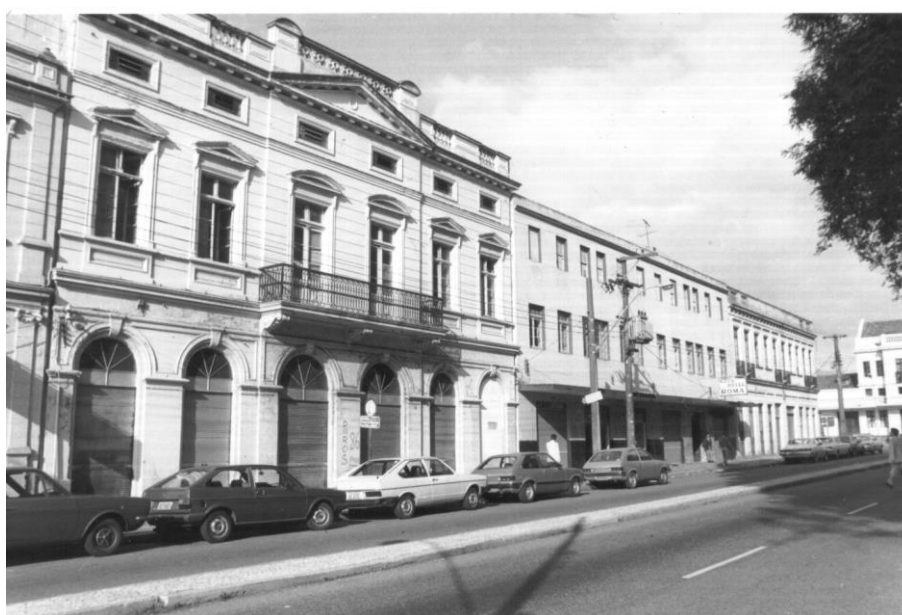
Figura 5.3.10 – Vista do prédio número 773 da Rua Barão do Rio Branco, na qual é possível ver suas características originais. (IPPUC, 2015)
