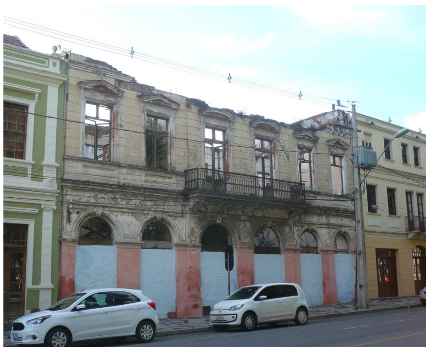
Figura 5.3.4 – Vista atual do prédio número 773 da Rua Barão do Rio Branco, que é o objeto de estudo e intervenção desta pesquisa. (AUTORA, 2015)
