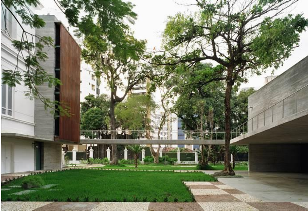
Figura 4.3.15 – Vista externa da passarela que conecta os edifícios do Palacete das Artes (BRASIL ARQUITETURA, 2015)
