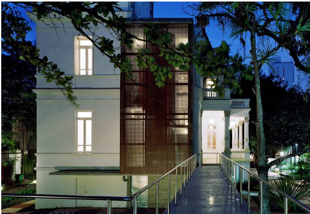
Figura 4.3.8 – Vista externa da nova torre de circulação vertical do Palacete das Artes (BRASIL ARQUITETURA, 2015)
