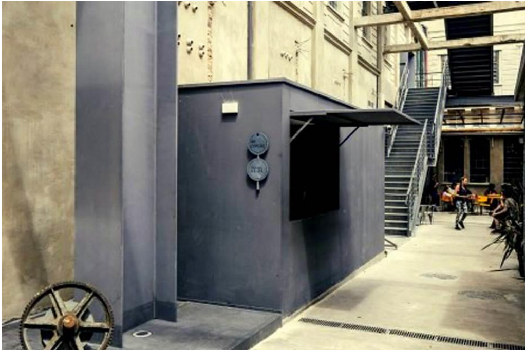
Figura 4.2.5 – Vista da bilheteria do Centro Cultural Red Bull Station (AMPLIA ENGENHARIA, 2013)
