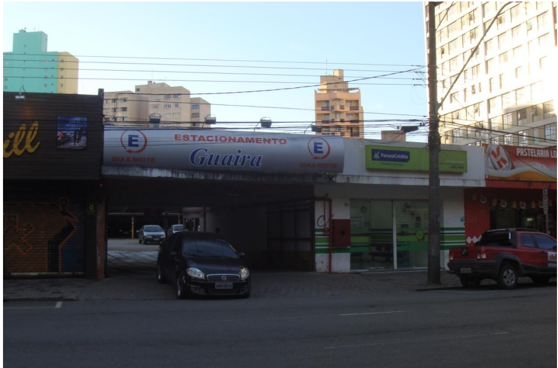
FIGURA 4.17: Acesso ao estacionamento que ocupa maior parte do lote. (FONTE: A autora, 2010).
