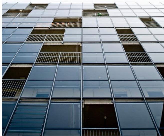
FIGURA 50 – REVESTIMENTO DE VIDRO NA CIRCULAÇÃO.
