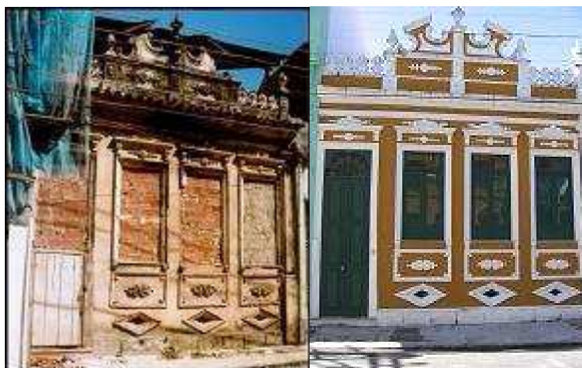
FIGURA 36 - RUA DIREITA DE SANTO ANTÔNIO - CASARÃO N.19 – SALVADOR – ANTES E DEPOIS DA INTERVENÇÃO (FONTE: PROJETO REABILITA, 2006).
