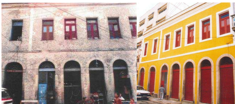
FIGURA 35 - SOBRADO DA RUA SENADOR POMPEU N. 34 - RIO DE JANEIRO – ANTES E DEPOIS DA INTERVENÇÃO (FONTE: PROJETO REABILITA, 2006).
