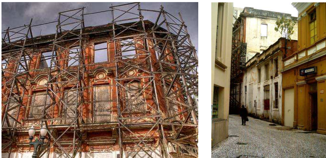
FIGURAS 84 E 85 – ESQ: VISTA DA RUA JOSÉ BONIFÁCIO; DIR: VISTA DA TRAVESSA PADRE JÚLIO DE CAMPOS. (FONTE: FLICKR / Arquivo de Autora, 2008).
