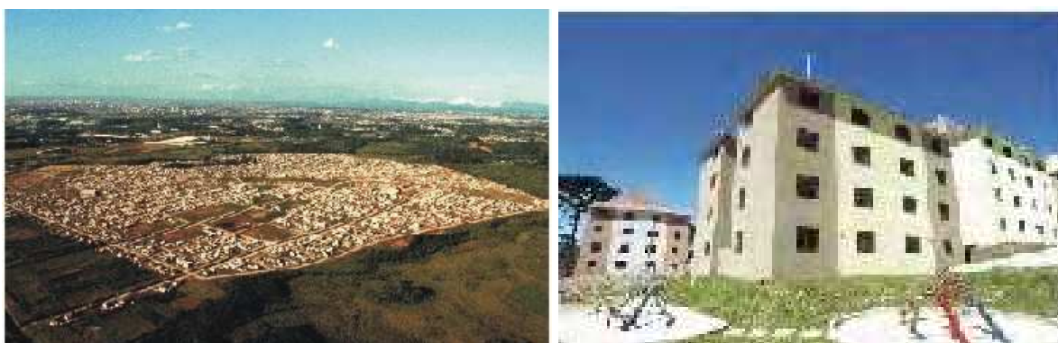
FIGURAS 05 E 06 – ESQ: ÁREA PARA REGULARIZAÇÃO FUNDIÁRIA; DIR: UNIDADES HABITACIONAIS ENTREGUES PELA COHAB EM CURITIBA (FONTE: COHAB-CT, 2008).
