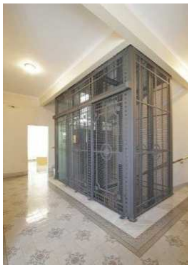
FIGURA 60 - VISTA DA CAIXA DE ELEVADORES COM GRADIL DECORADO, MARCAS DA DÉCADA DE 1920 (FONTE: REVISTA AU, 2007).
