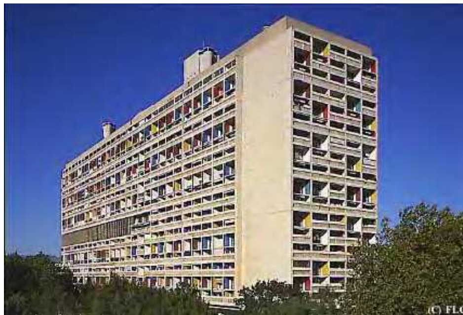
FIGURA 01 - UNIDADE DE HABITAÇÃO DE MARSELHA, DE LE CORBUSIER (FONTE: THEURBANEARTH, 2008).
