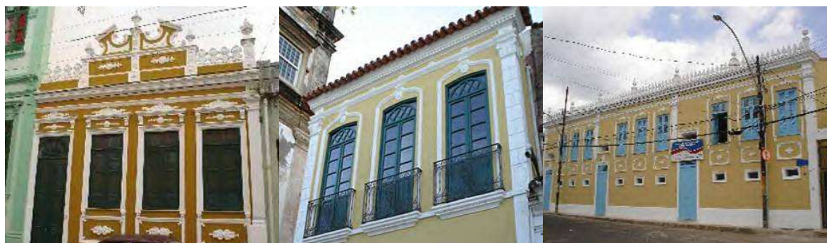
FIGURA 37 - PROJETOS REALIZADOS PELO PROJETO REMEMORAR: 1. CASARÃO N.53 DA RUA JOAQUIM TÁVORA; 2. CASARÃO N.56 DA RUA RIBEIRO SANTOS; 3. CASARÃO 30/40/42 DA RUA DERALDO DIAS (FONTE: PROJETO REMEMORAR, 2008).
