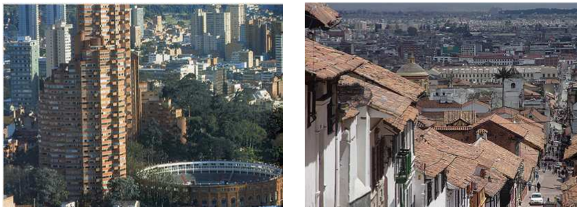
FIGURAS 22 E 23 - REABILITAÇÃO E PRESERVAÇÃO DE ÁREAS HISTÓRICAS E CONSTRUÇÃO DE NOVAS ESTRUTURAS PARA HABITAÇÃO (FONTE: ERU, 2008).
