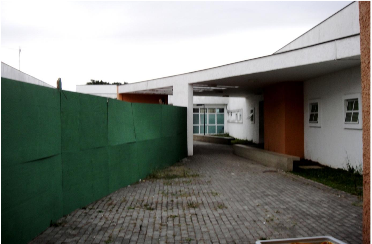
FIGURA 3.36 – Pátio interno com tapume da obra em andamento (FONTE: A autora, 2011)
