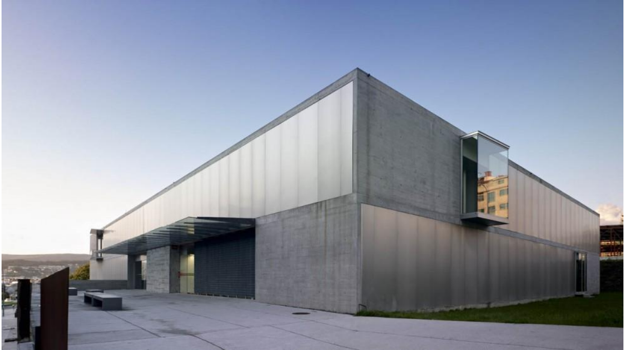
FIGURA 3.4 – Centro de Saúde A Parda, Pontevedra – Espanha (FONTE: ROSENBERG, 2011)
