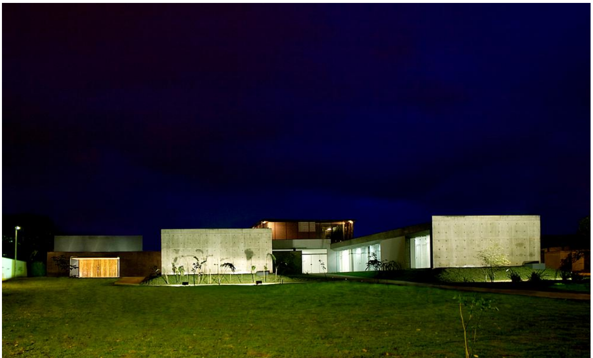
FIGURA 3.21 – Vista noturna do Centro Ambulatorial (FONTE: BASULTO, 2010)
