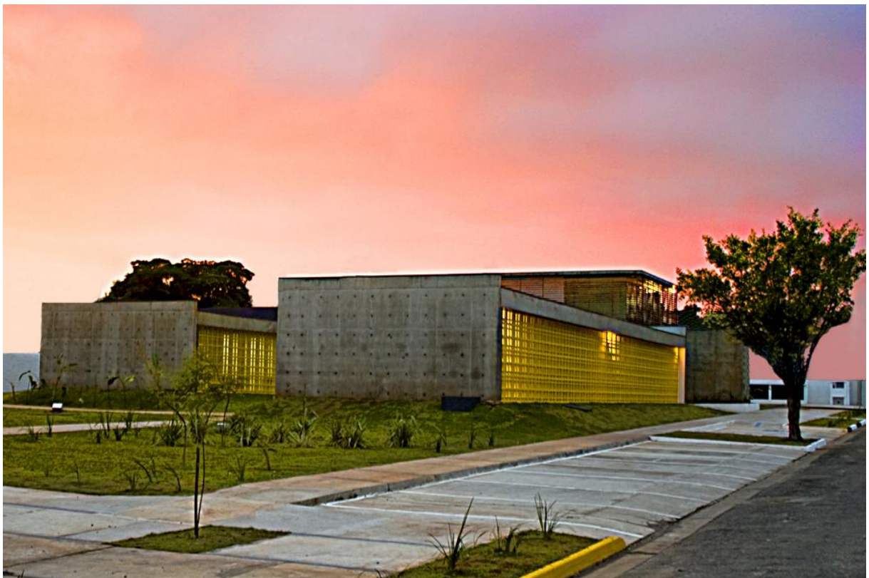
FIGURA 3.16 – Centro Municipal de Especialidades Médicas de Suzano – SP (FONTE: BASULTO, 2010)
