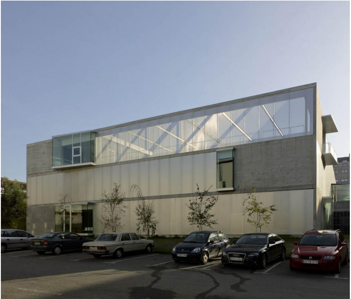
FIGURA 3.3 – Fachada posterior do Centro de Saúde A Parda (FONTE: ROSENBERG, 2011)
