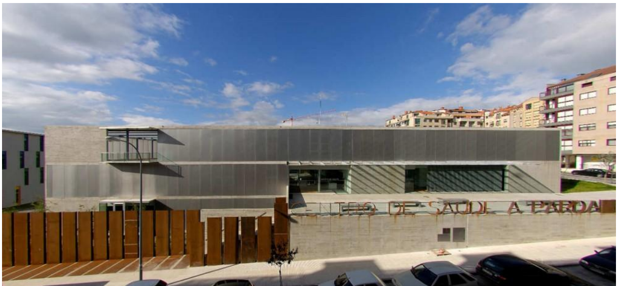
FIGURA 3.1 – Centro de Saúde A Parda, Pontevedra – Espanha (FONTE: ROSENBERG, 2011)
