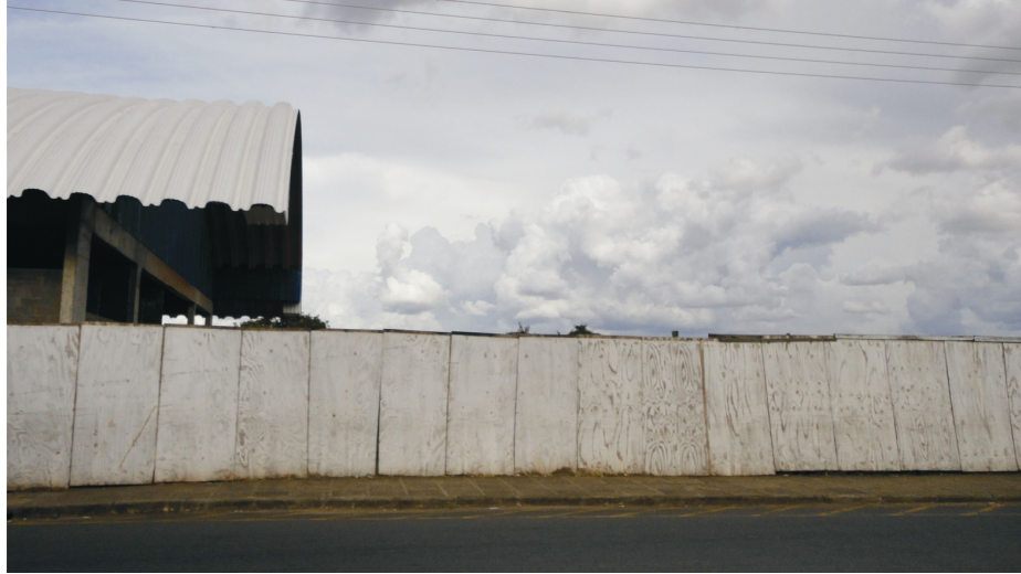
FIGURA 5.8: Tapume e cobertura metálica em Ponta Grossa. FONTE: autora.
