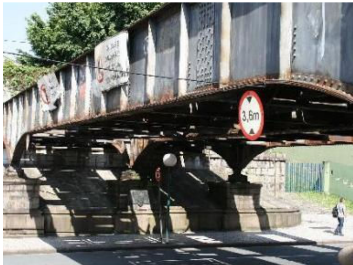
FIGURA 4.42: Ponte Preta, sobre a Rua João Negrão. FONTE: Jornal E., 2011.
