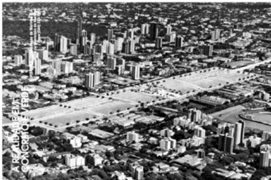
FIGURA 2.13: laje de cobertura do túnel por onde passam os trilhos, no centro de Maringá. FONTE: Meneghetti, 2009.
