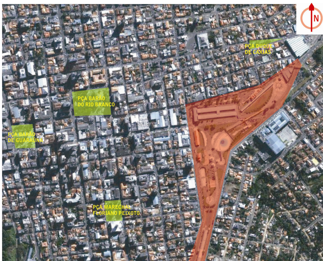
FIGURA 3.15: As praças centrais, geralmente no entorno de igrejas, oferecem poucas opções de lazer. A área da ferrovia seria uma boa opção para a criação de um espaço com o objetivo principal de oferecer lazer urbano. FONTE: Google Earth, 2011; autora.
