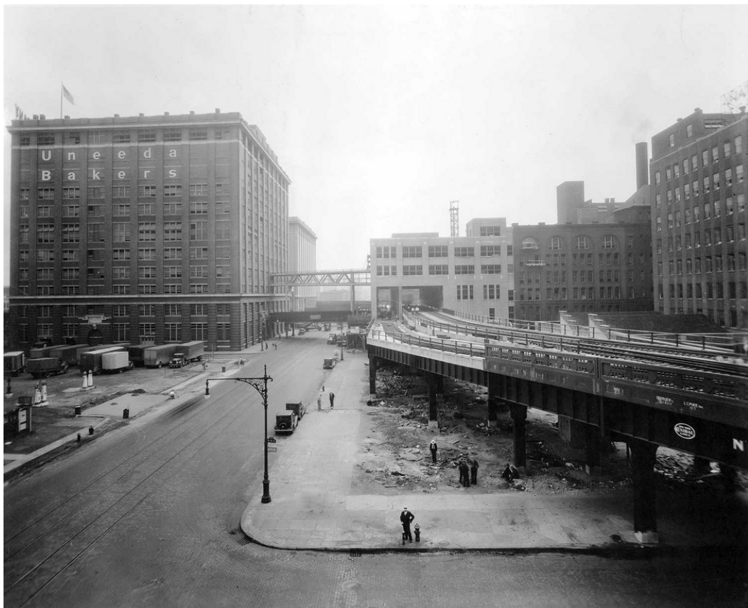
FIGURA 4.2: A High Line na época da construção da via elevada. Os trilhos passavam por dentro de algumas fábricas, facilitando assim o trabalho de carga e descarga dos vagões. FONTE: Galleries, 2011.
