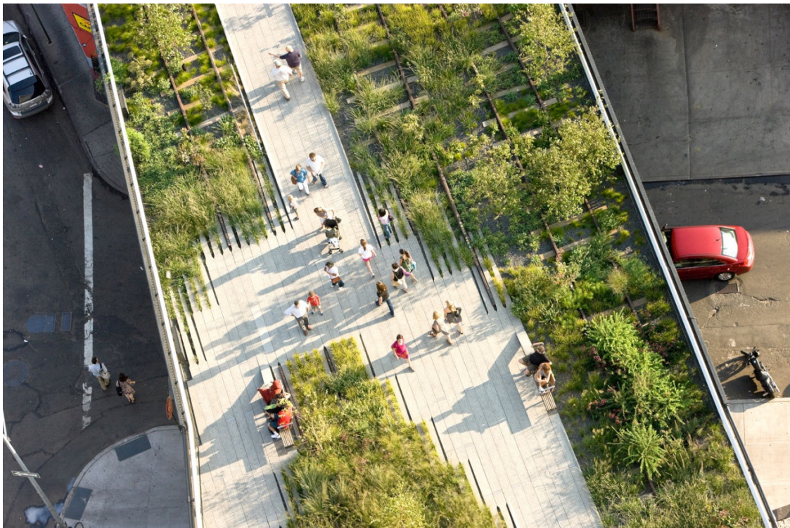
FIGURA 4.5: A transição entre pavimento e vegetação acontece sutilmente, por meio de frestas que remetem ao crescimento espontâneo de vegetação nas rachaduras da calçada. FONTE: Galleries, 2011.
