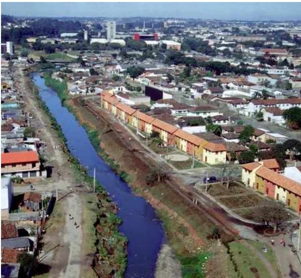
FIGURA 5.1 VILA DOS OFÍCIOS.
