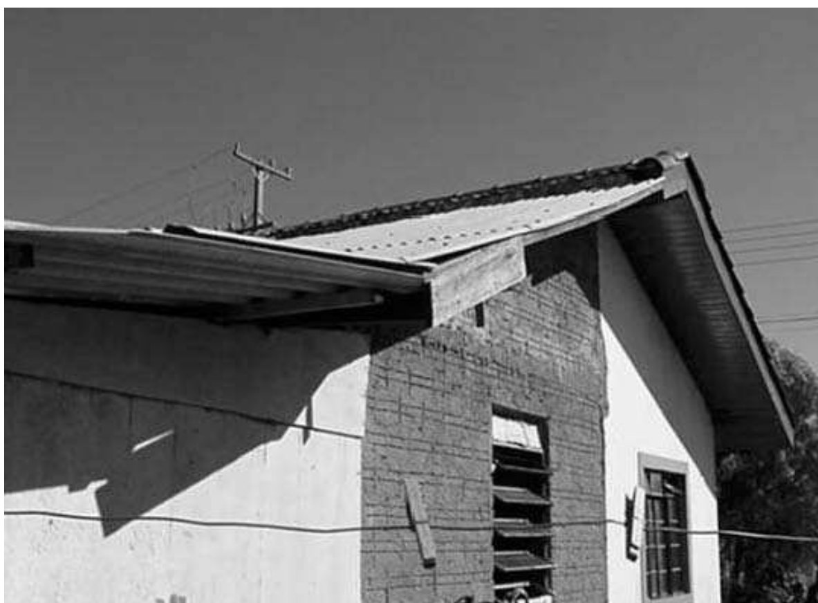
FIGURA 4.8 CONJUNTO RIO CHAPECÓ I: INTERFACE ENTRE BEIRAL ORIGINAL E EXPANDIDO.
