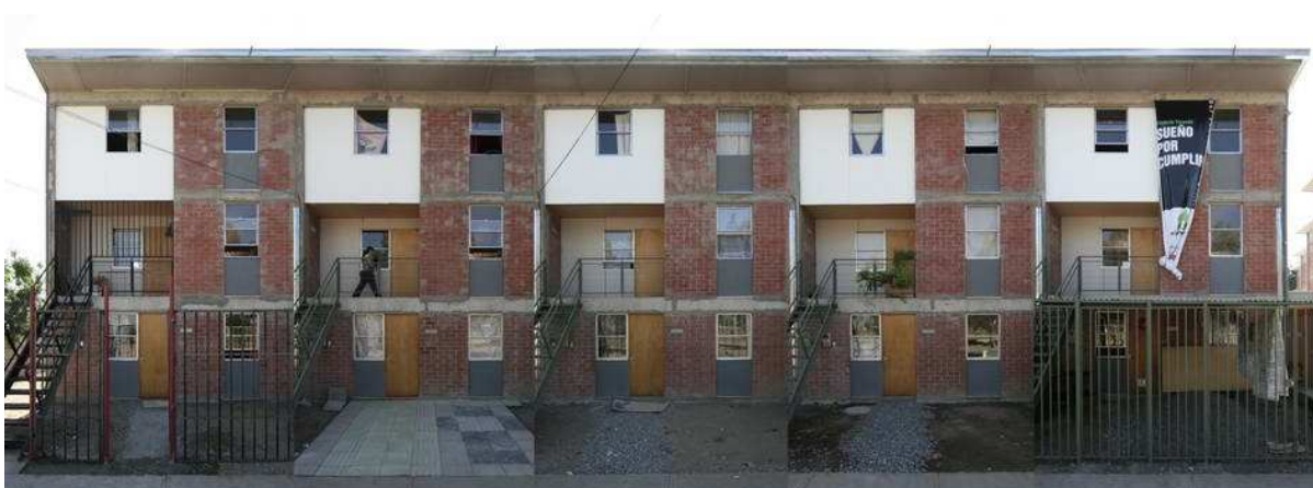
FIGURA 4.17 CONJUNTO LO ESPEJO: FACHADA APÓS OCUPAÇÃO. FONTE: ELEMENTAL (2009).
