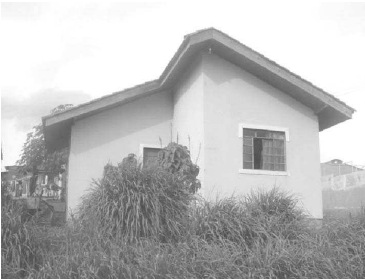
FIGURA 4.4 CONJUNTO RIO CHAPECÓ I: HABITAÇÃO ORIGINAL.
