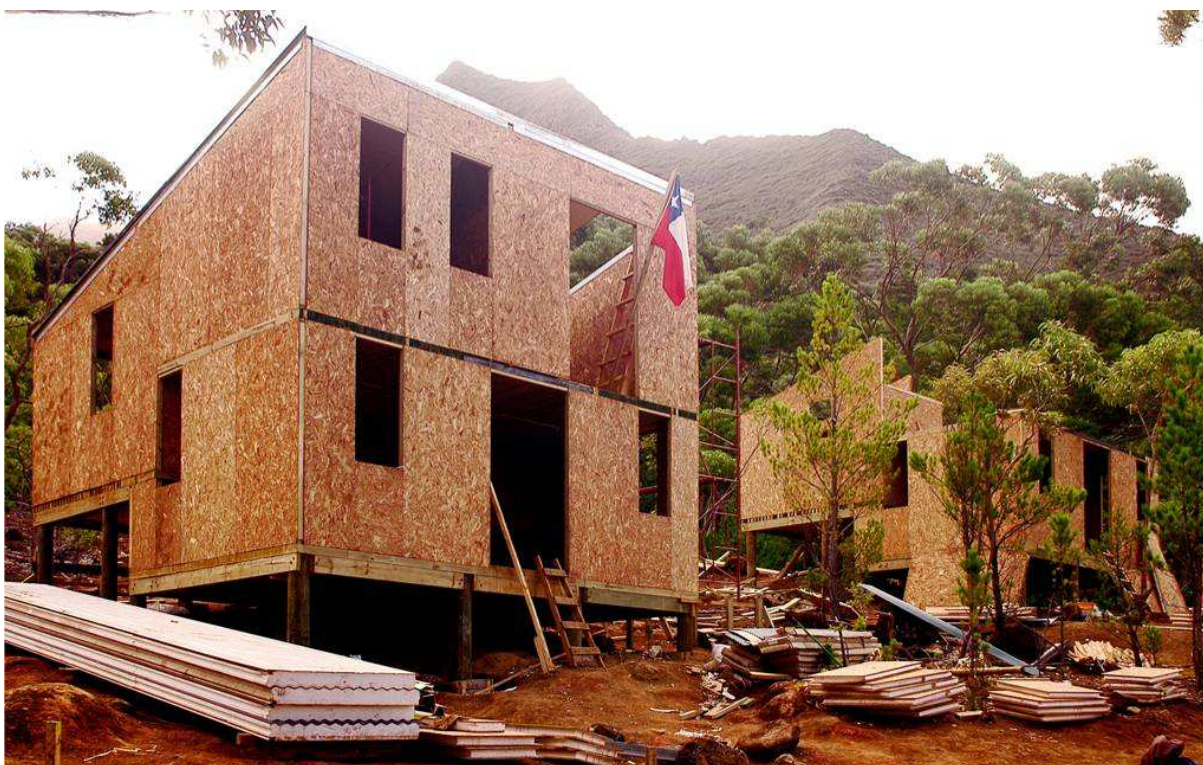
FIGURA 4.29 CONJUNTO SANTA CLARA: CONSTRUÇÃO DAS HABITAÇÕES.
