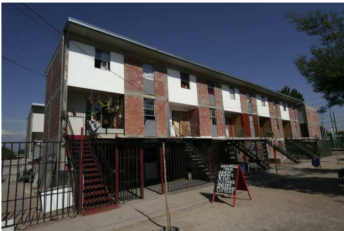
FIGURA 4.23 CONJUNTO LO ESPEJO: VISTA CONJUNTO OCUPADO.
