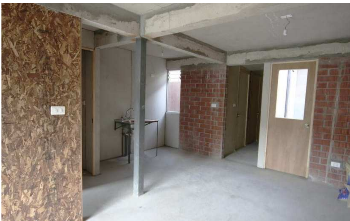
FIGURA 4.18 CONJUNTO LO ESPEJO: AMBIENTE COZINHA/SALA INICIAL. FONTE: ELEMENTAL (2009).
