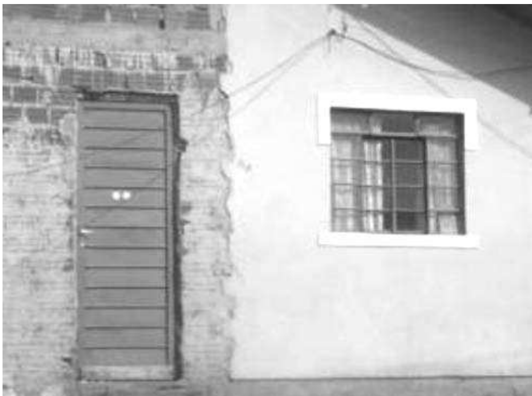
FIGURA 4.5 CONJUNTO RIO CHAPECÓ I: AMPLIAÇÃO REALIZADA COM DIFERENTE PADRÃO CONSTRUTIVO.
