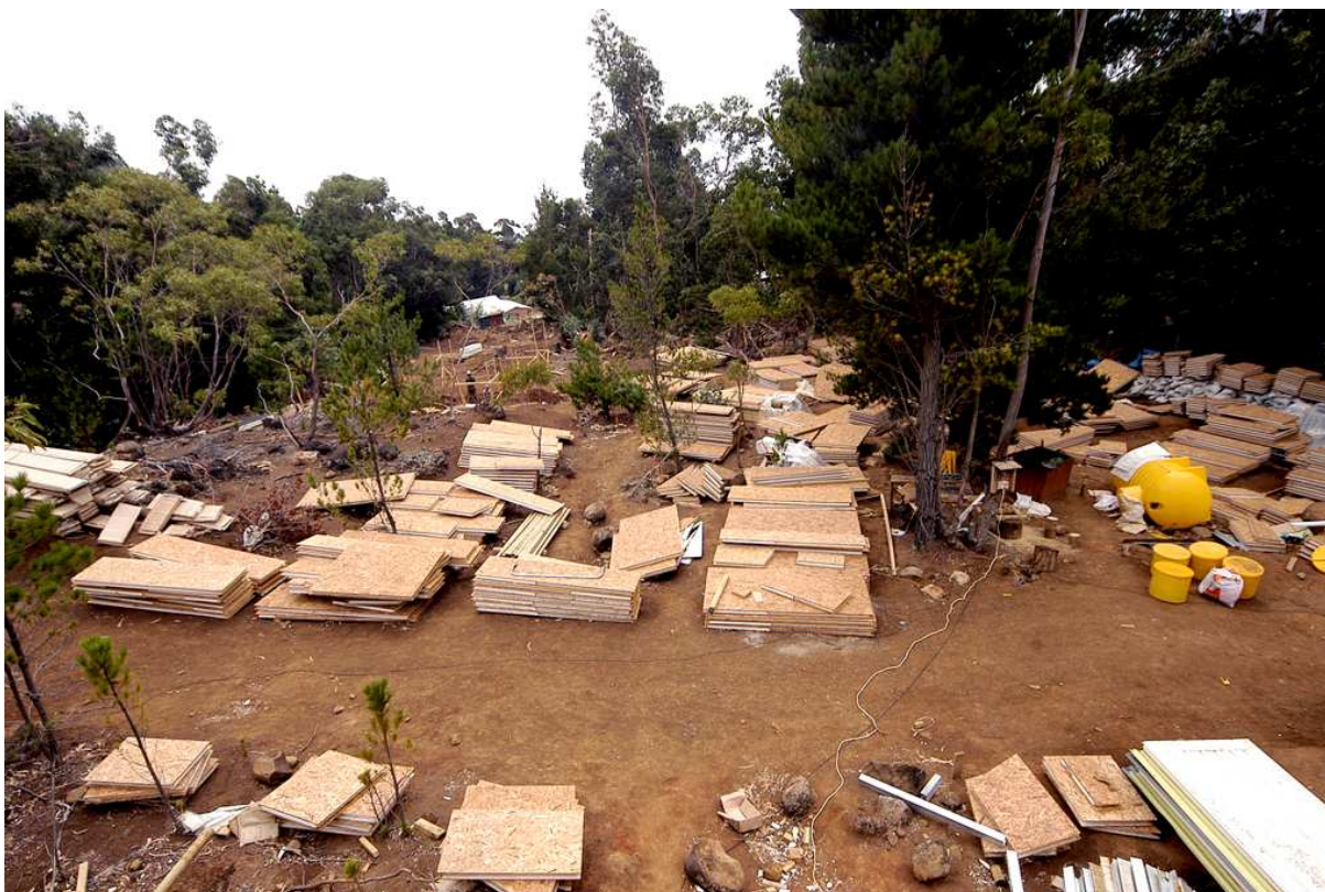
FIGURA 4.27 CONJUNTO SANTA CLARA: COMPONENTES PRÉ-FABRICADOS. FONTE: PLATAFORMA ARQUITECTURA (2009).
