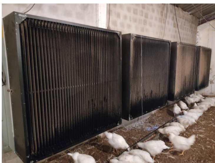
FIGURA 7: Light traps instalados em exaustores
