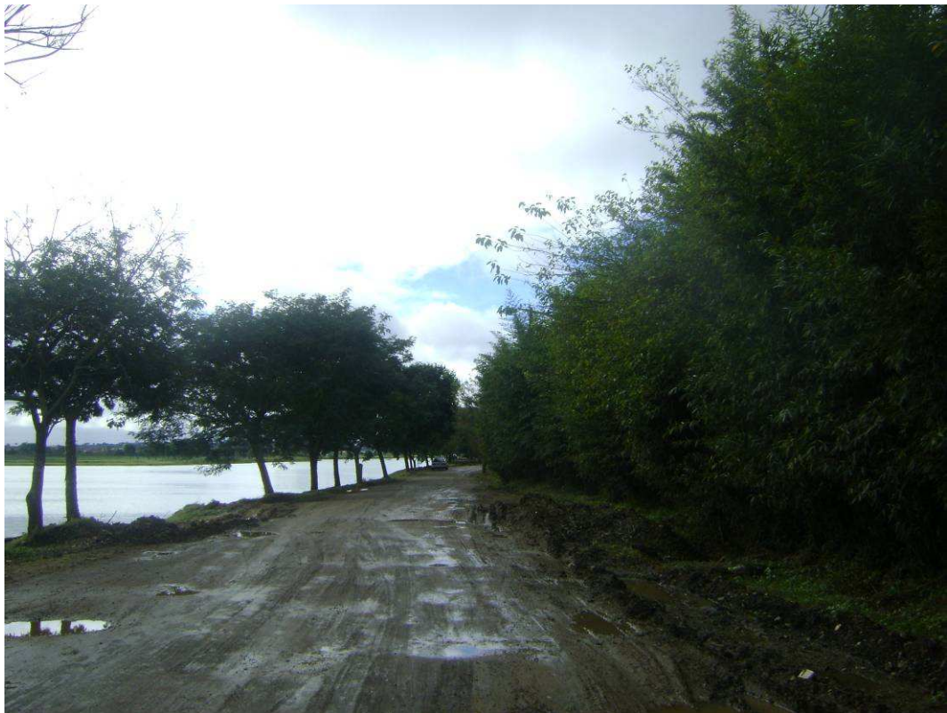
Fig. 4.12 – Rua esburacada que circunda a raia náutica (FONTE: A AUTORA, 2010).
