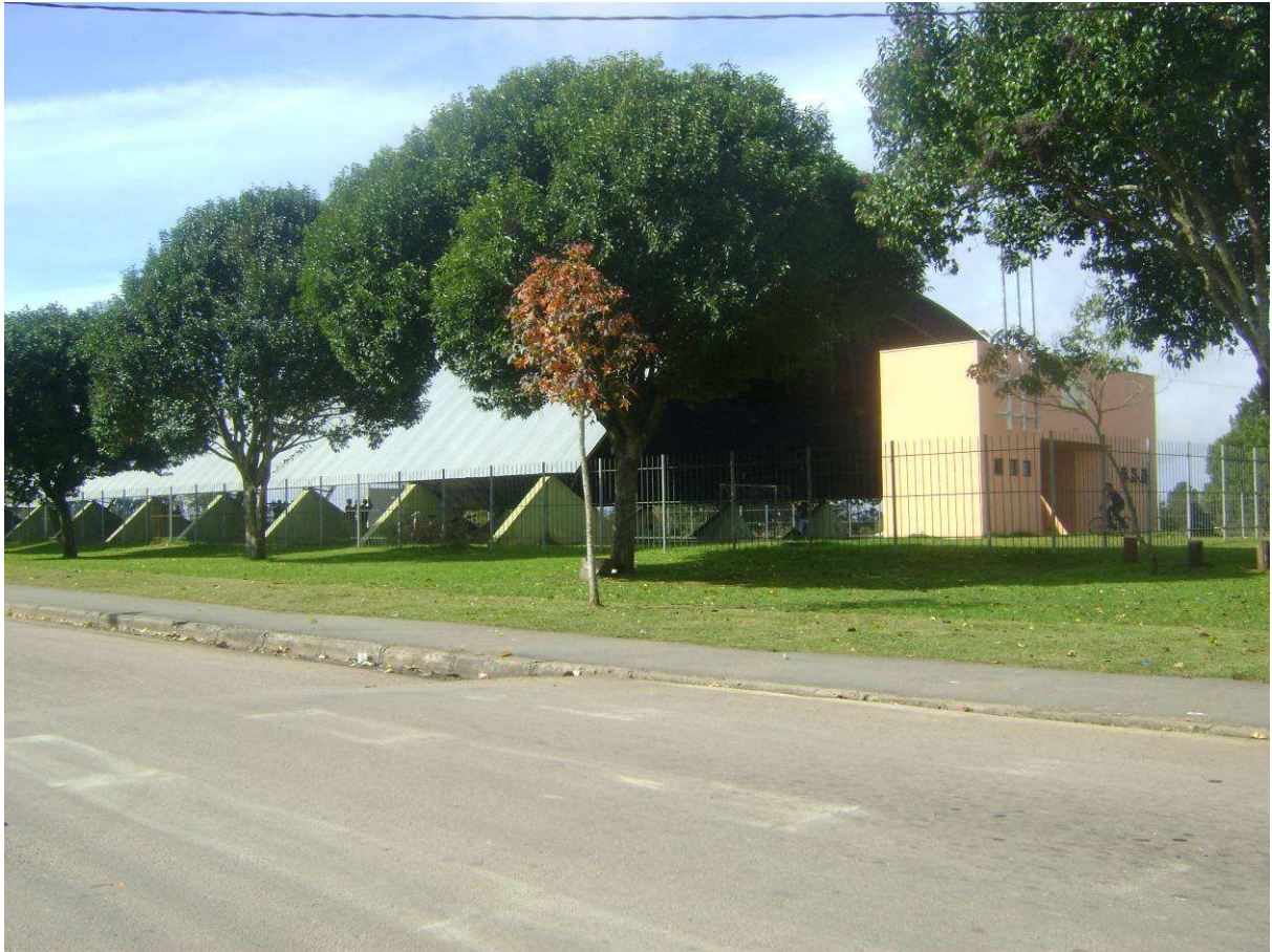
Fig. 4.9 – Quadra coberta do Parque do peladeiro (FONTE: A AUTORA, 2010).
