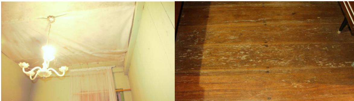
FIGURA 102 – FORRO DE MADEIRA COM A PROTEÇÃO DE TELA E PISO DANIFICADO POR CUPINS
