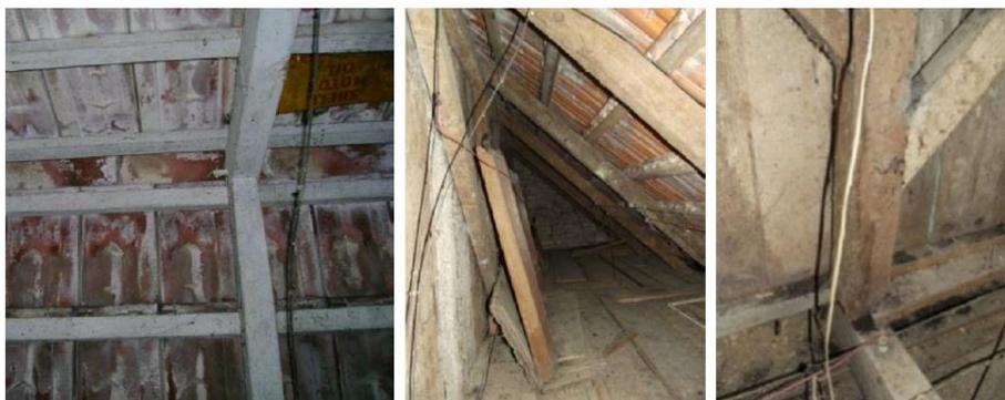
FIGURA 97 – ESTRUTURA DO TELHADO DA CASA DE ALVENARIA, PONTALETES E MÃOS
