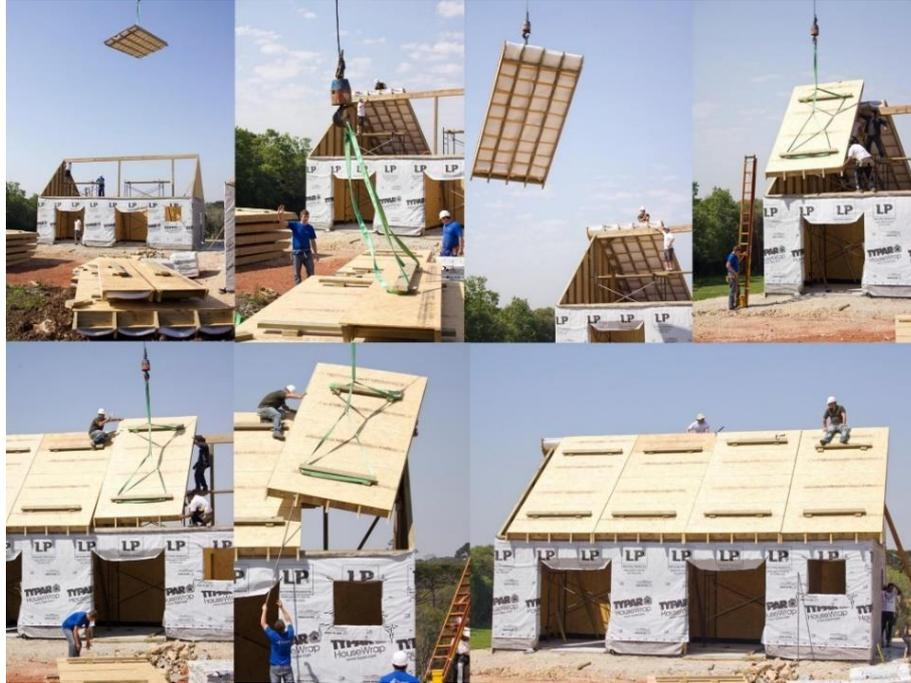
FIGURA 58 – FOTOS DA CONSTRUÇÃO COM PLACAS DE LÂMINA DE MADEIRA DE REFLORESTAMENTO
