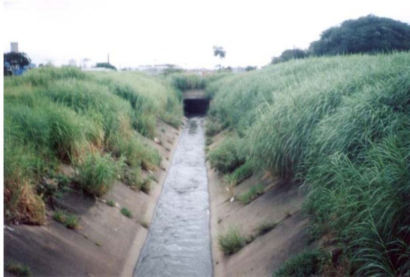
FIGURA 27: Córrego Rincão, à montante da Estação Penha de Metrô. Ao fundo, transição de seção trapezoidal para galeria retangular de concreto. FONTE: PDMAT, 1999.
