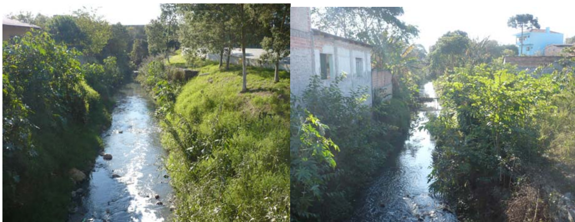
FIGURA 62: Cruzamento do Rio Ressaca com a Rua Almirante Alexandrino.
