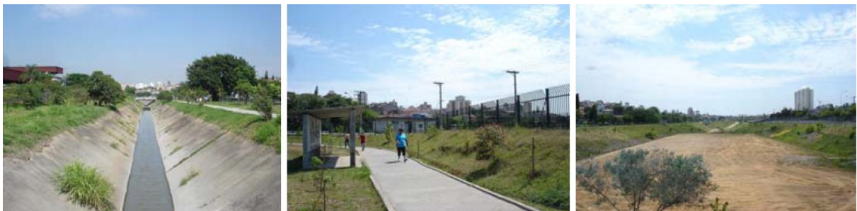
FIGURA 31: Trecho do córrego Rincão, passeio de pedestre atual e vista do patamar mais alto do reservatório secundário. FONTE: Sanches, 2007.
