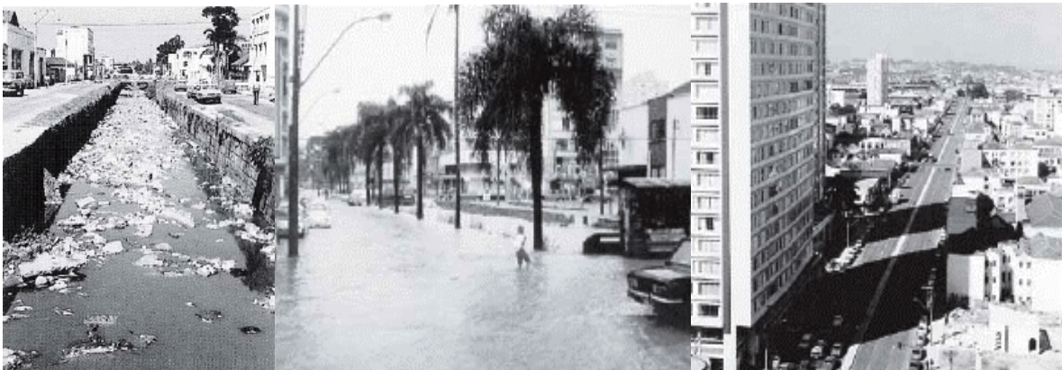
FIGURA 34: Evolução da canalização do Rio Belém na Avenida Mariano Torres na década de 1970. Segundo Hayakawa (2009), o fechamento do canal foi realizado sob um canteiro central para que no dia em que o rio estivesse despoluído, a canalização aberta pudesse ser retomada. FONTE: PMC (apud DUARTE, 2006)
