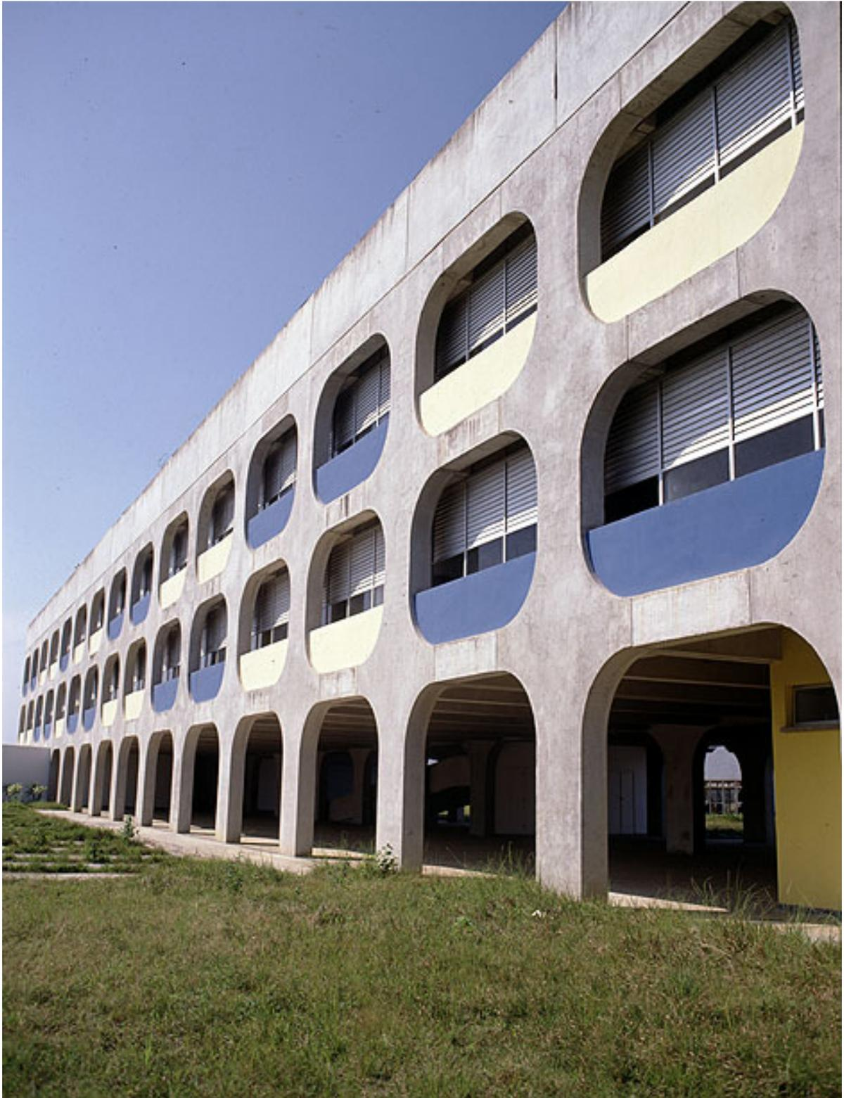
Figura 19 - Fachada do CIEP - Destaque para o elemento pré-fabricado. Fonte: CRALMEIDA
