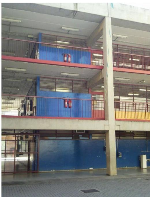
Figura 23 - Destaque para o elemento pré-fabricado. Fonte: Souza (2010)
