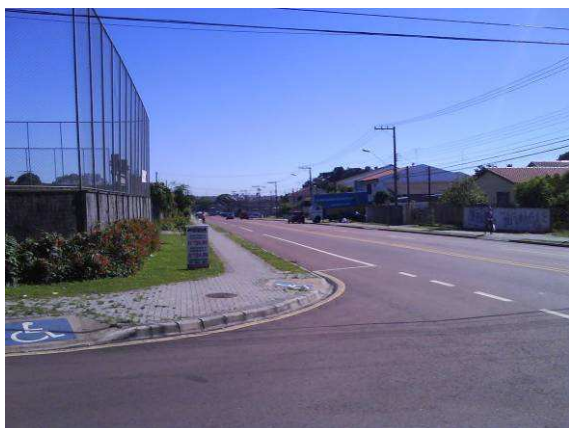
FOTO 11: Rua recentemente asfaltada. FONTE: Acervo da Autora, 2009.
