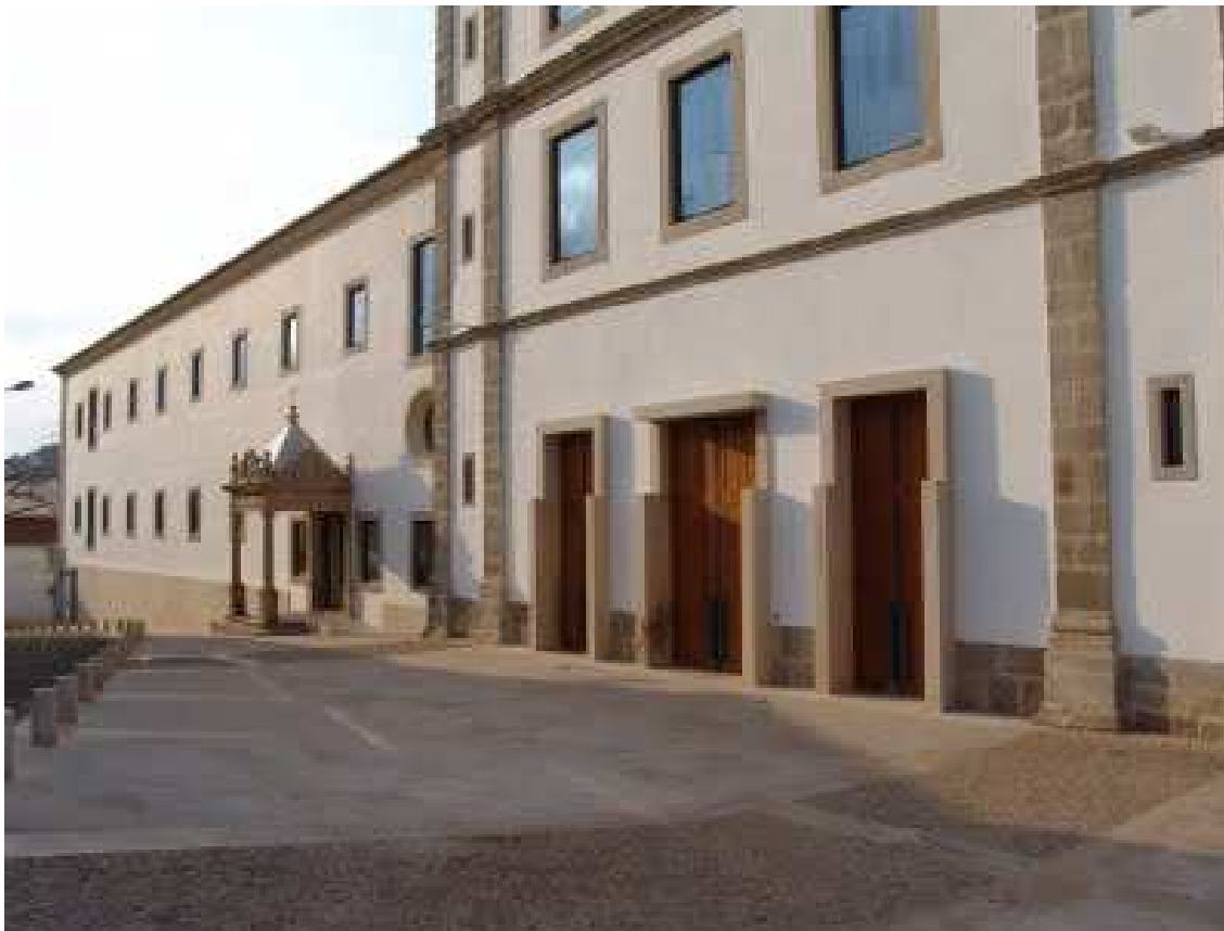
FIGURA 8: Edifício do centro histórico de Portalegre. FONTE: PORTALEGRE, 2009b.
