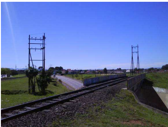
FOTO 17: Viaduto do Trem. FONTE: Acervo da Autora, 2009.
