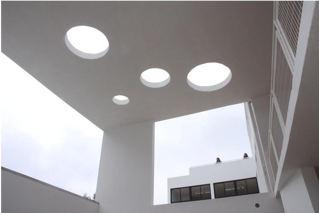
Figura 48 – Lajes com Orifícios
