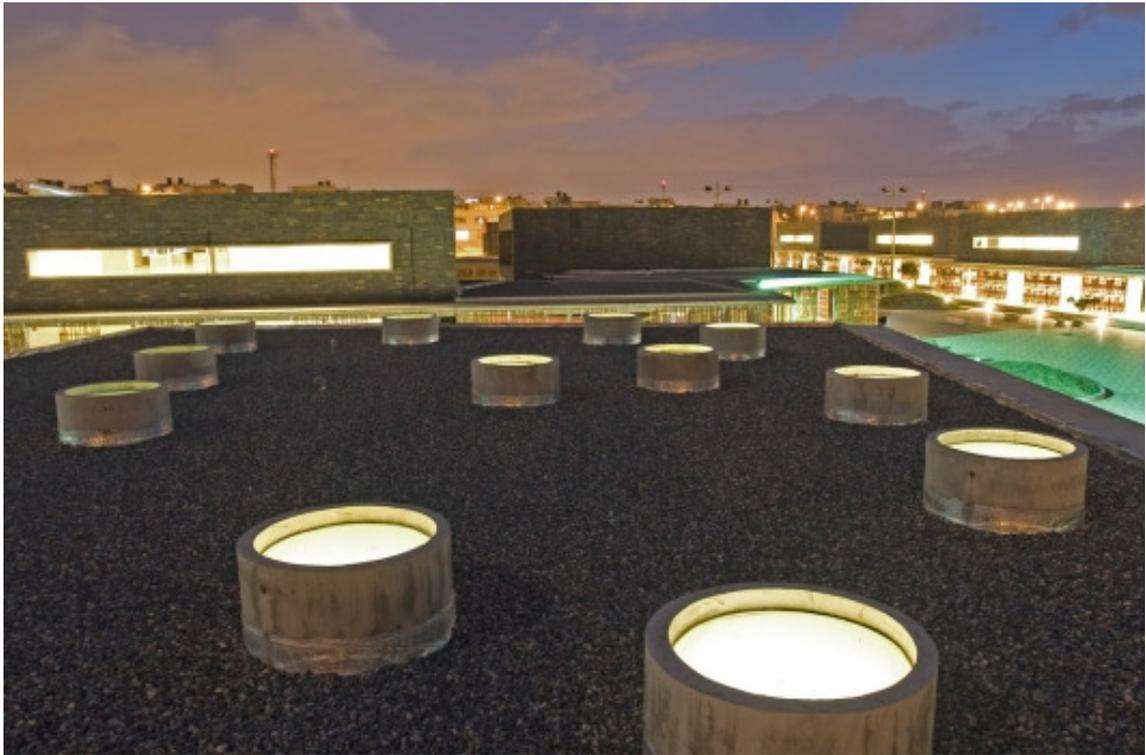
Figura 30 - Cobertura: Argila Expandida e Zenitais
