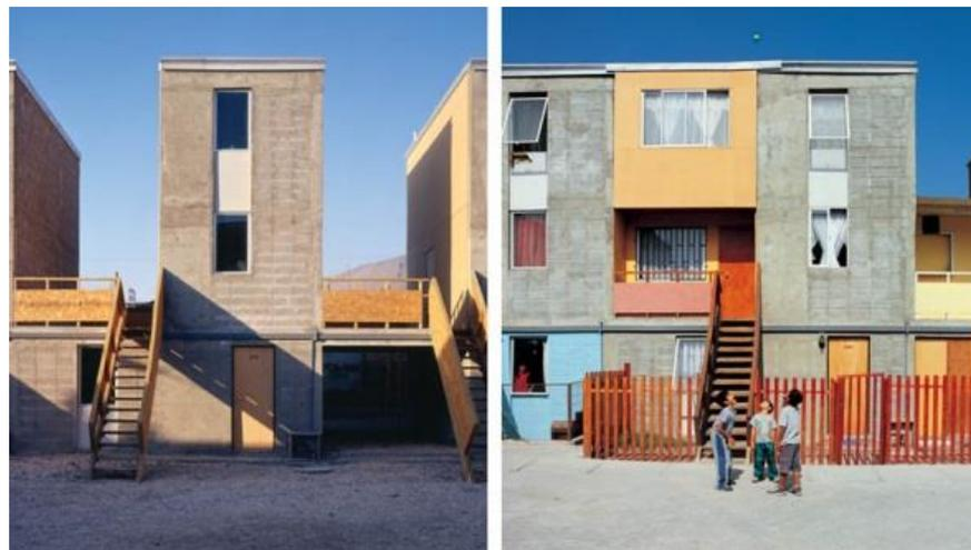
FIGURA 13 – COMPARAÇÃO DO EXTERIOR DA EDIFICAÇÃO ANTES E DEPOIS DAS EXTENSÕES – QUINTA MONROY
