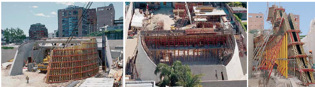
FIGURA 146 – Construção da sinagoga Amijai (FONTE: PERI, 2009)
