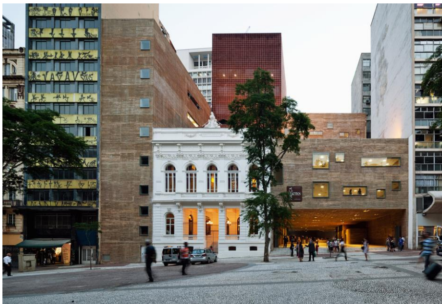
Figura 10 - Fachada do edifício sede do CDMSP ladeada pelos novos volumes. O respeito a alinhamentos, alturas, e neutralidade de cores e materiais promove a integração do novo ao antigo de forma não agressiva. Os tons terrosos e a simplicidade do novo projeto destacam por contraste a arquitetura rebuscada da casa antiga, pintada em branco. Fonte: Archdaily
