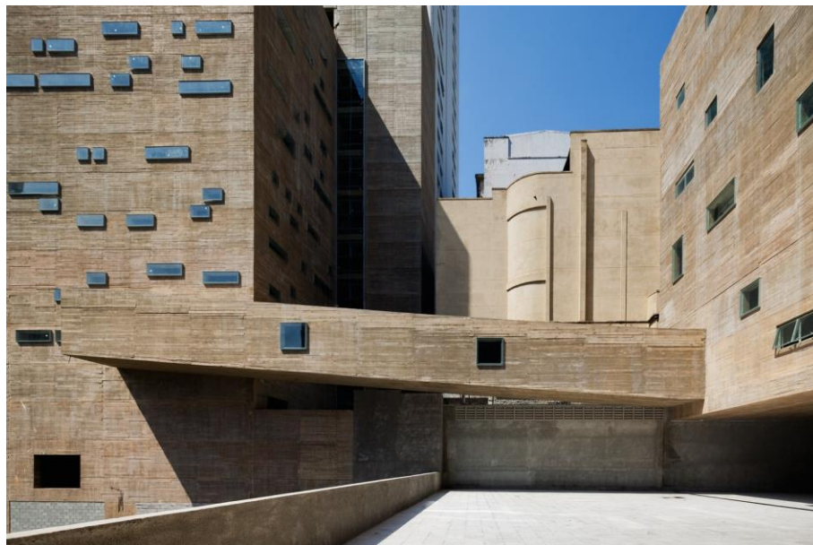
Figura 18 - Janelas de alto desempenho no isolamento acústico. Destacadas do plano da fachada e posicionadas em formas e tamanhos aparentemente aleatórios, conferem um tom lúdico ao edifício austero. Fonte: Archdaily
