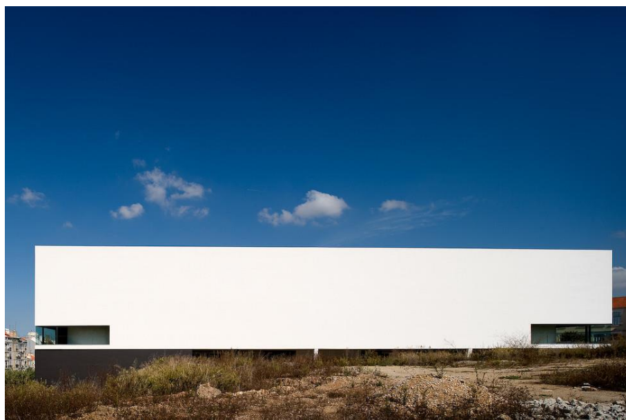
Figura 22 - Poucas aberturas para o exterior como solução de isolamento acústico e resposta à ausência de vistas interessantes. Fonte: Archdaily
