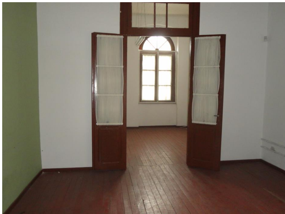
Figura 45 - Pavimento superior fotografado em 2013. Observa-se a manutenção do piso em madeira, com réguas estreitas, e das esquadrias internas. Fonte: IPPUC
