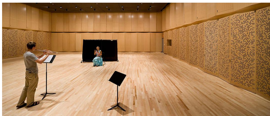
Figura 33 – Sala voltada à prática musical. Nas paredes, piso e teto observam-se revestimentos em madeira instalados em diferentes ângulos e com diferentes padrões de perfuração, elementos importantes no condicionamento acústico do espaço. Fonte: Archdaily.
