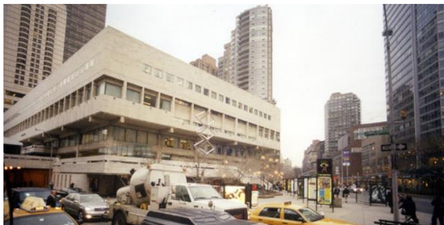
Figura 29 - Edifício sede da escola antes da intervenção de Diller Scofidio + Renfro. Fonte: The City Review
