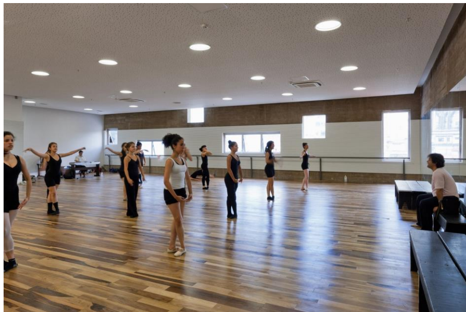
Figura 17 - Sala de dança. Observa-se a mesma opção por forros voltados ao condicionamento acústico. Lajes flutuantes diferenciam estas salas daquelas de prática musical. Fonte: Archdaily
