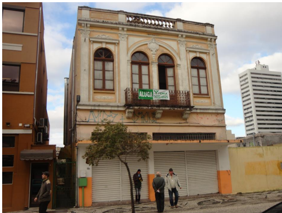
Figura 47 - Fachada do sobrado no ano 2013. Fonte: IPPUC
