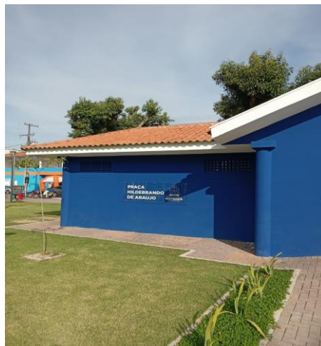
Figura 22 - Banheiro da Praça Central, Maio/2023.
