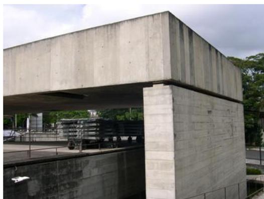
Figura 70 - Junção da viga e pilar da obra
