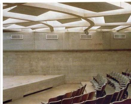
Figura 73 - Laje nervurada do auditório
