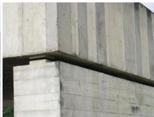
Figura 71 - Detalhe da fenda entre a viga e o pilar
