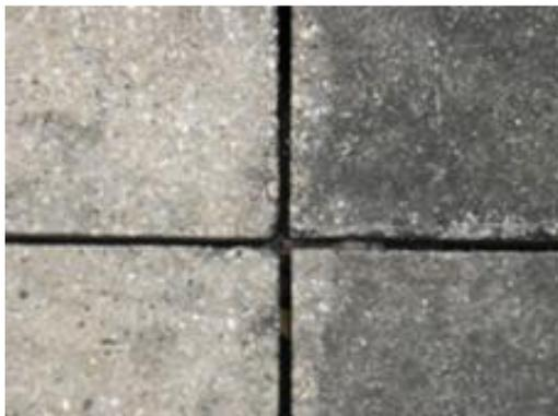
Figura 74 - Detalhe reentrâncias na laje
