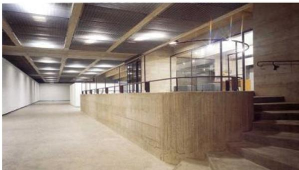
Figura 72 - Laje nervurada no interior do edifício
