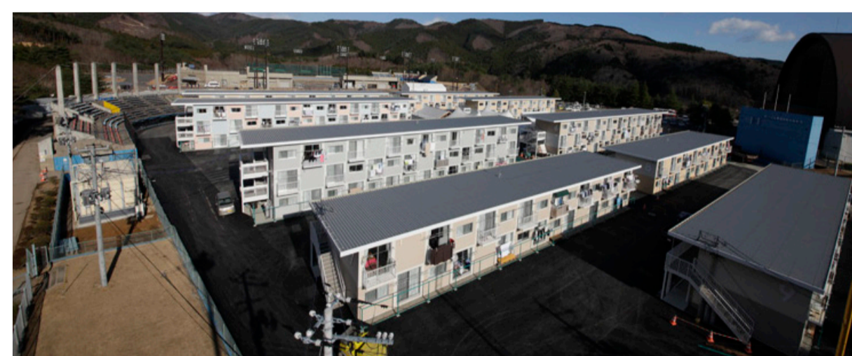
Habitação Temporária em Contêiner, Japão, 2011 Implantação : Onagawa, Japão Autoria: Shigeru Ban
