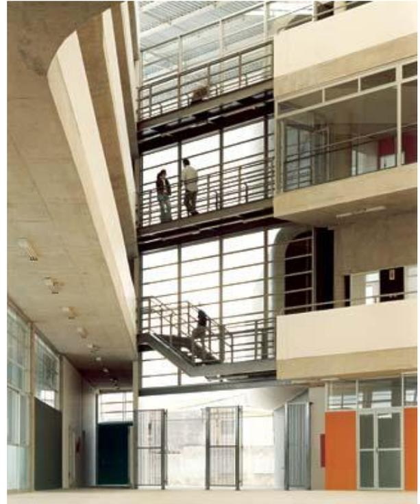
FIGURA 27 – ESTRUTURAS METÁLICAS QUE INTERLIGAM OS CORREDORES DE CONCRETO
